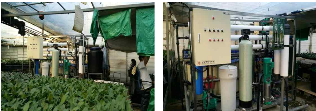
<그림 3-48> 산소 발생기 설치 재배 온실
