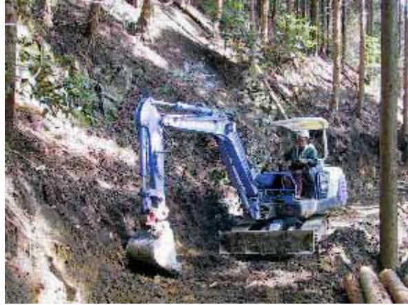
그림 183. 임내작업차도(W=2m)의 개설상황 절취높이를 낮게 설계하는 것이 중요
