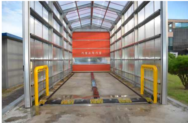
<그림 19> 차량 진입로 선 세척 단계 추가: 차량 하부 및 바퀴 유기물 제거 능력 개선, (소독액 농도 유지를 고려하여 세척과 소독용 펌프는 별개 작동 설계)
