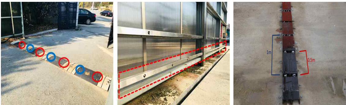
<그림 18> 소독노즐 추가 및 간격 변경: 기존(파랑색), 추가 및 간격 변경(붉은색)
