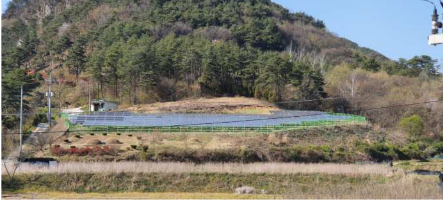
<그림 3-33> 관촌면 관촌2구 마을단위 99kW 태양광발전소
