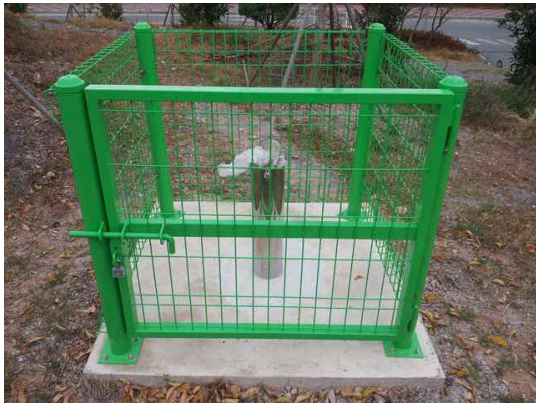
(a) 관측공 굴착, 기초, 보호시설 설치
