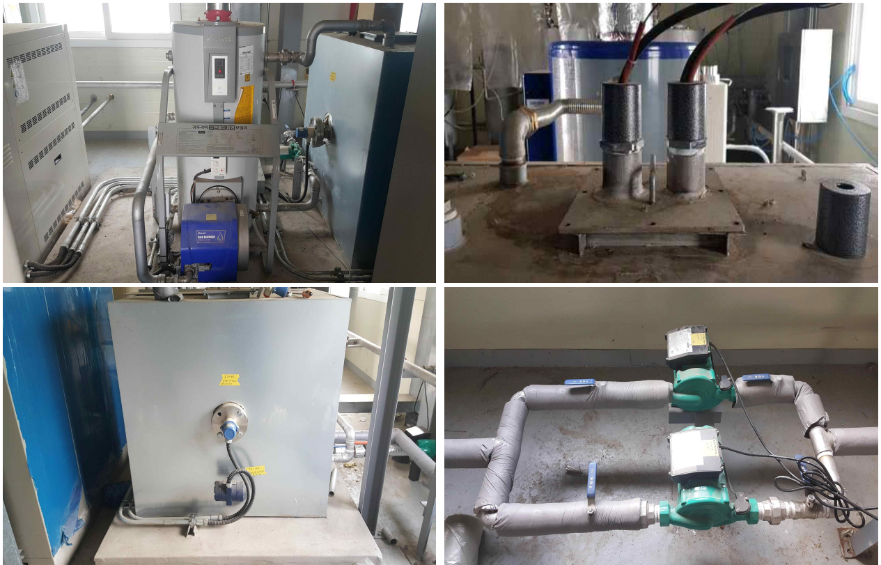
그림 2.7.55. 혐기소화조 운동조절부 설치전경(기존시설 수정활용)
