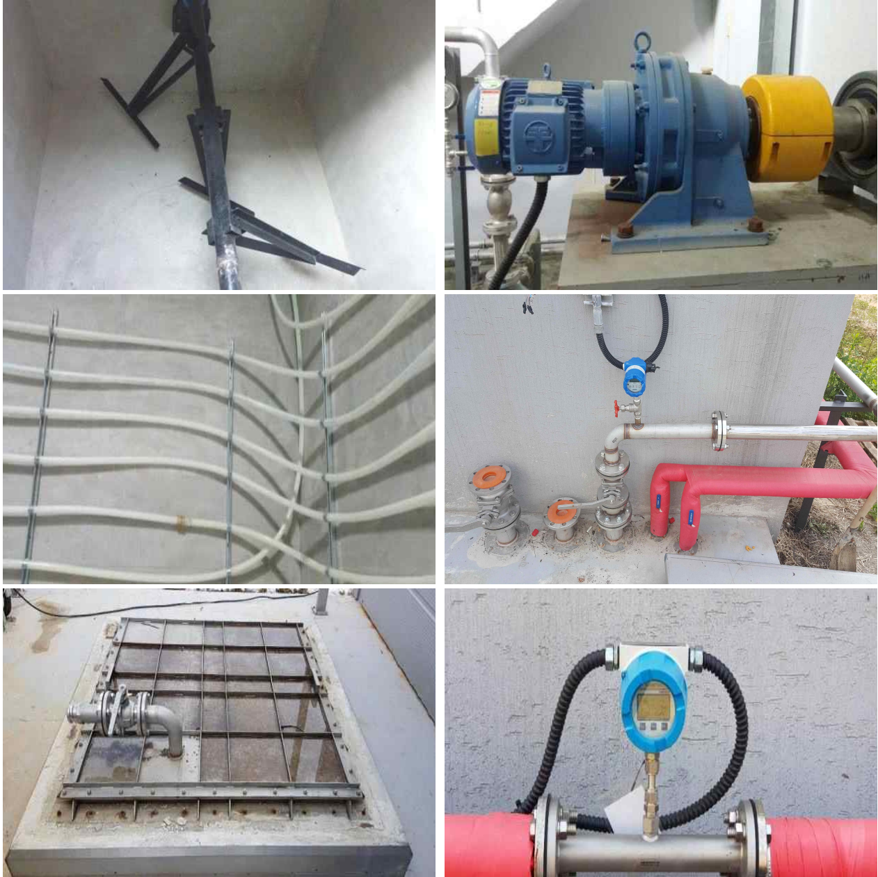
그림 2.7.55. 습식힘기소화조 제작 설치 전경(기존시설 보완 활용)
