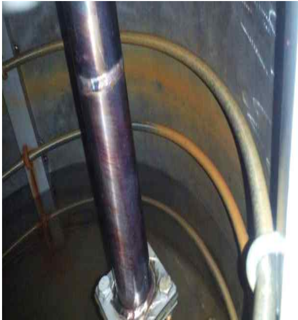
(고온액상발효반응기 내 온수순환파이프) (고온액상발효 및 열병합(온수회수) 장치) 그림 2.7.102 고온액상발효반응기 및 열병합(온수회수) 장치
