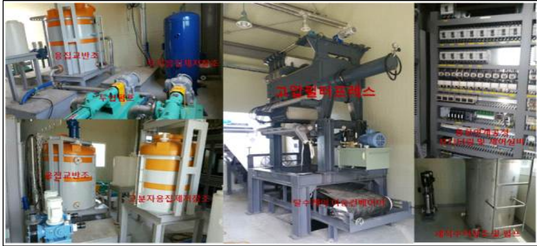
그림 2.7.63. Pilot plant급 고액분리 장치 현장구축사진, 기존시설 보완
