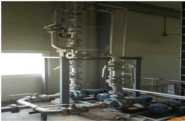
그림 2.7.56. 원료유입부, 소화액유출 및 순환부 설치전경(기존시설 수정활용)
