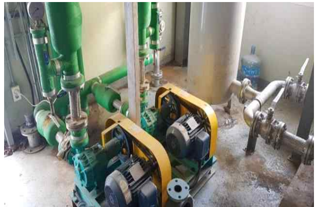
그림 2.7.56. 원료유입부, 소화액유출 및 순환부 설치전경(기존시설 수정활용)
