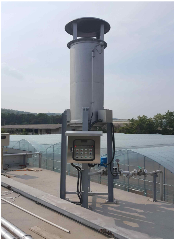
그림 2.7.57. 가스유출부 설치전경(기존시설 활용)
