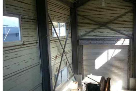
그림 2-5-34. 가스축적에 따른 시설 부식모습
