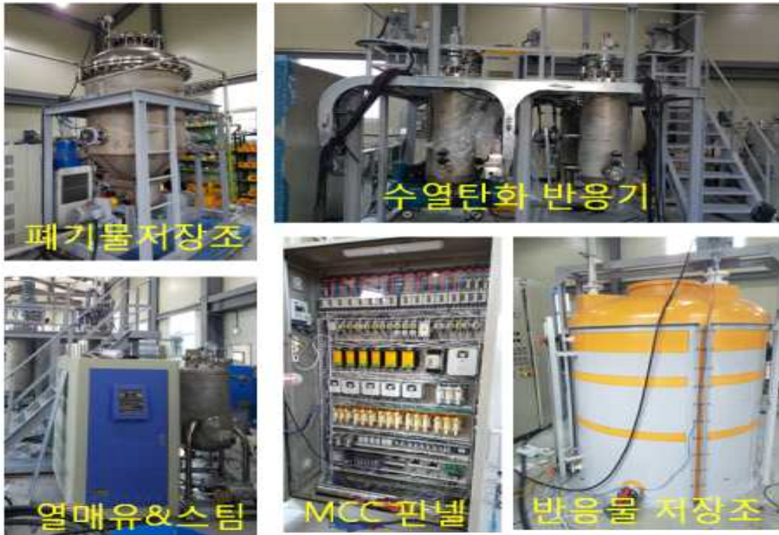
그림 2.7.58. Pilot plant급 수열탄화 단위공정별 설비제작 사진
