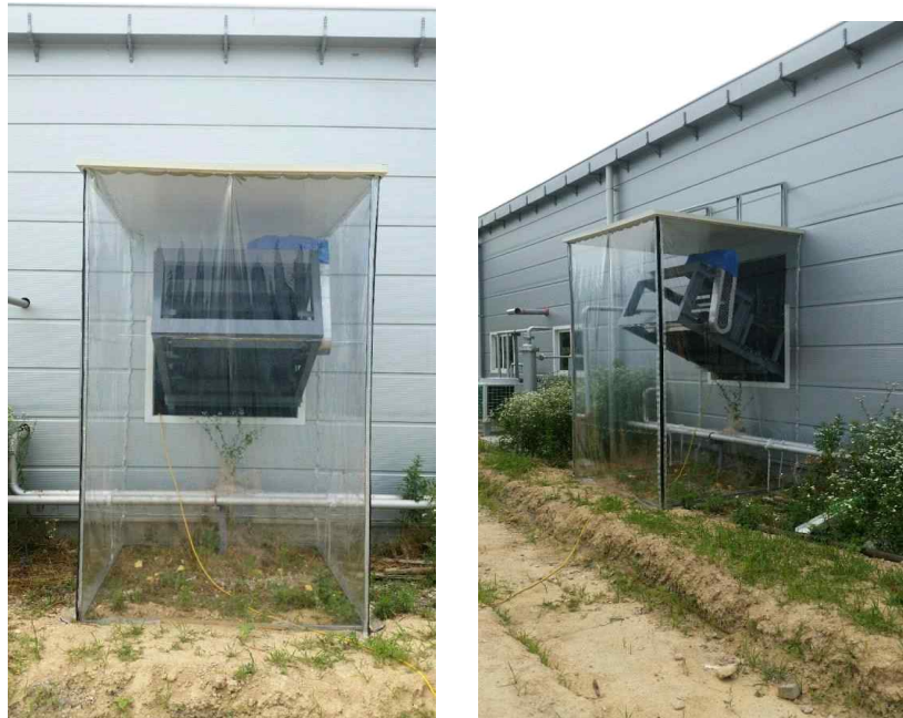
그림 2.7.64. Pilot plant급 고액분리 장치 현장구축사진, 기존시설 보완
