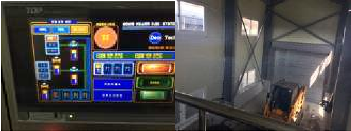
그림 2.6.33. 약취제어 시스템 설치 사진
