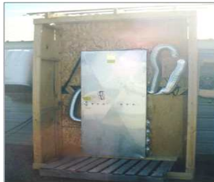
돈사에 적용된 악취 제어용 오존 발생기 그림 1.3.13. 악취제어용 방풍림과 오존발생기 모습
