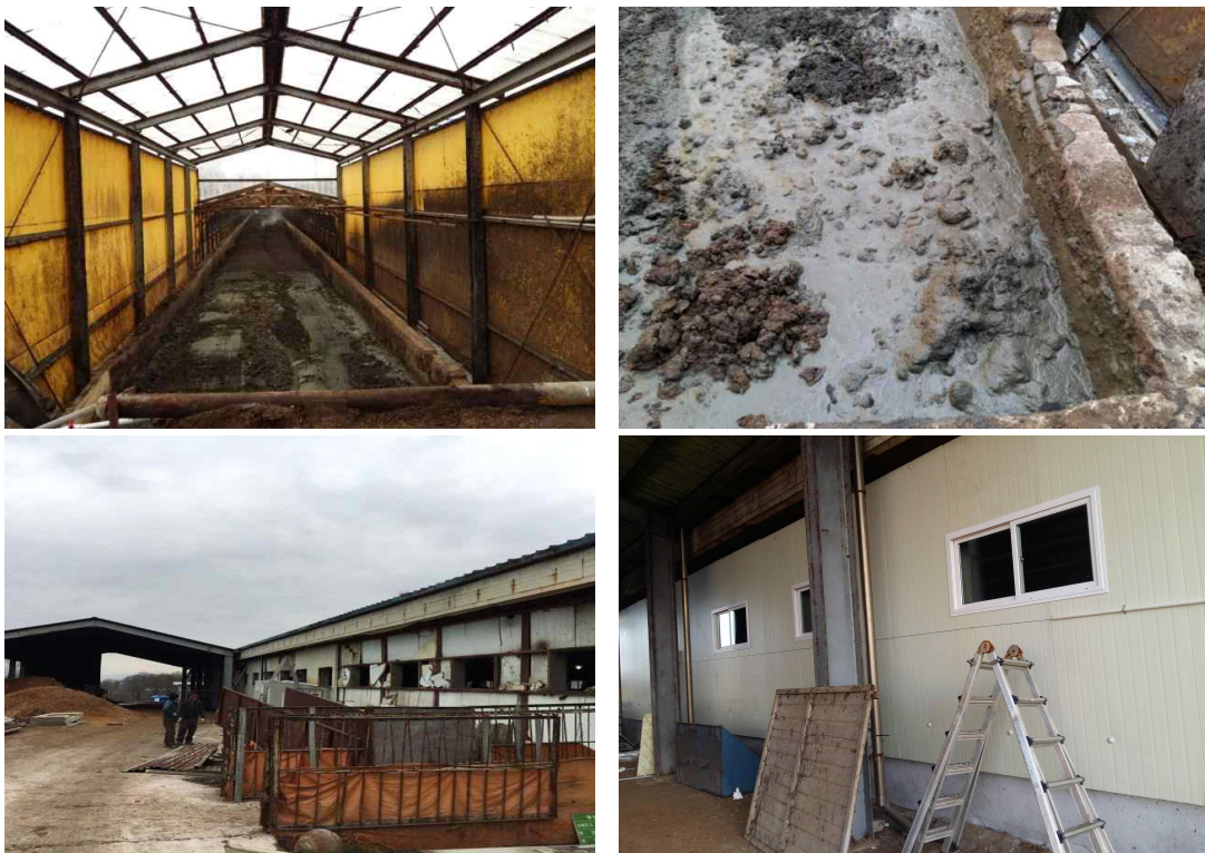
그림 2.5.10. 돈사 리모델링 및 돈분 이상발효 문제로 인한 분뇨 교체작업
