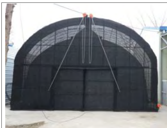
○ 비가림재배사 설치 완료 전경
