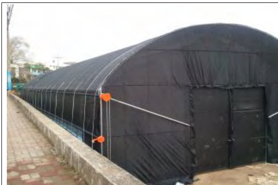
○ 재배사 설치 완료
