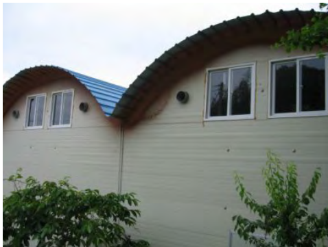
버섯재배사 광창 설치
