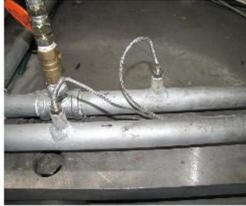
그림 1-32 냉각수 온도 측정을 위한 PRTD 타입의 온도 센서.
