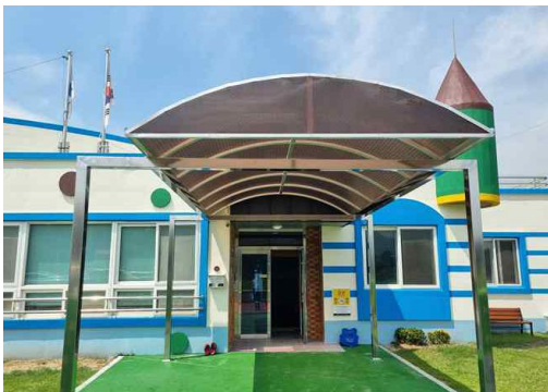
입구 캐노피, 정비 및 바닥 방수페인트 공사
