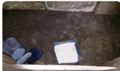
모돈사 전실에 별도의 구획공간이 없어 전용 장화 갈아신기와 방역복 갈아입기가 어려움 ※ 장화 갈아신기용 발판 설치가 안 되어 있음
