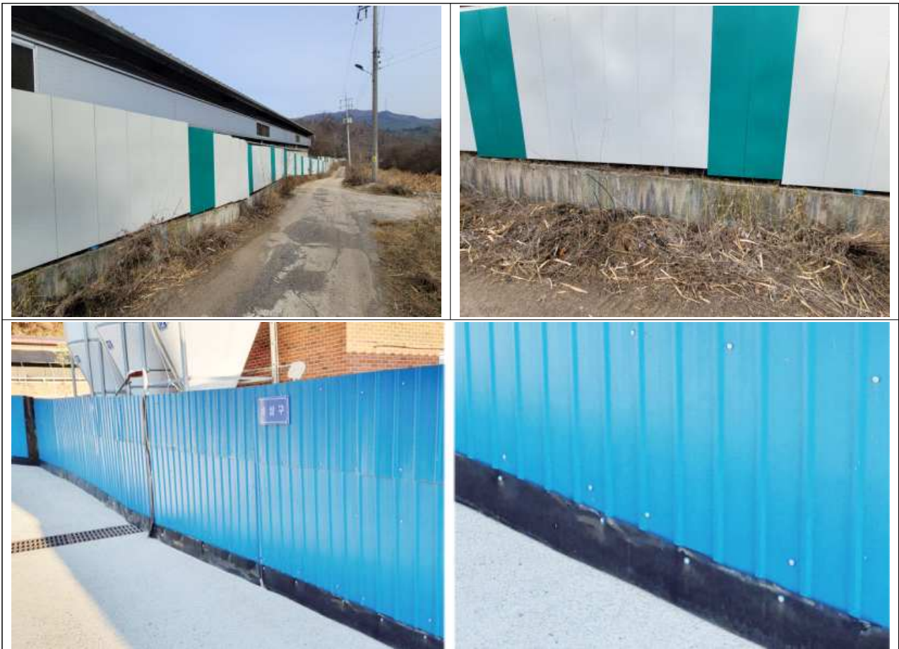
그림 2.130. 지면에 틈이 발생 되게 설치한 양돈 농가 외부울타리 모습(위)과 집쥐 등 야생동물 침입을 막기위해 바루를 고무패드로 막은 외부 울타리 모습(아래, 한돈농장 의무시설 설치 가이드북).
