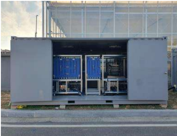
그림 1-58 스마트팜 혁신밸리 연료전지 시스템 구축 현장
