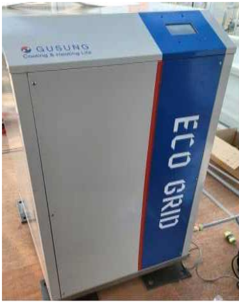
그림 2-53. 합성가스 연소기 및 냉난방 시스템 설치 모습
