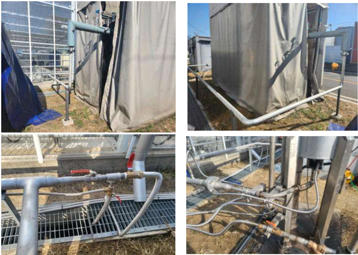
그림 2-50. 농산부산물 반탄화 연료 가스화기 생산 합성가스 공급 연결라인
