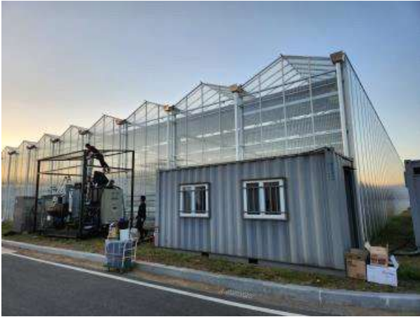
그림 2-48. 농산부산물 반탄화 연료 가스화기 스마트팜 실증사이트 연계 이송 및 설치작업
