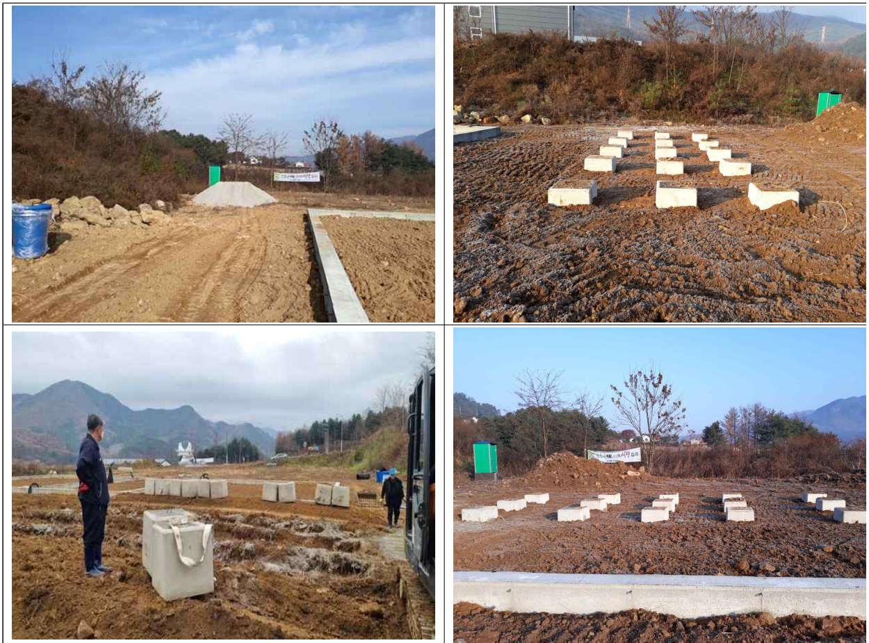
[그림 5. 실증 온실내 축냉조 및 축열조 설치용 기초석 조성 사진]
