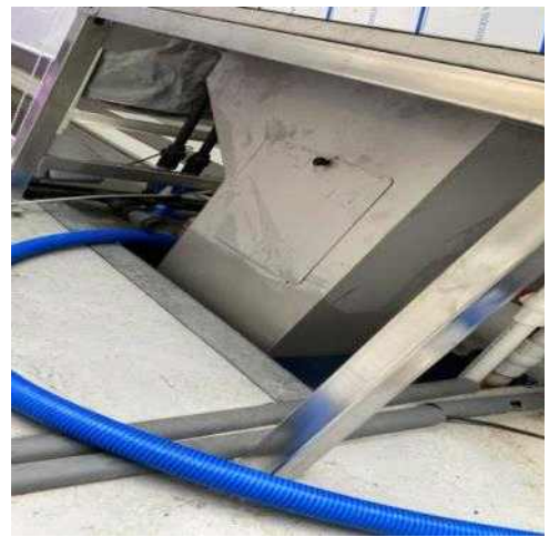
(a) 아이슬러시 제빙 시스템 설치 (b) 분산 축냉조 연계 부 전경 그림 53. 분산 축냉조 탄산 저장 용량 증대를 위한 아이슬러시 제빙 시스템 설치 전경
