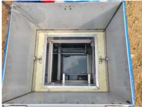
[그림] 생산된 자연냉열 저장을 위한 진공단열재(VIP)기반 초고단열 축냉조 설치
