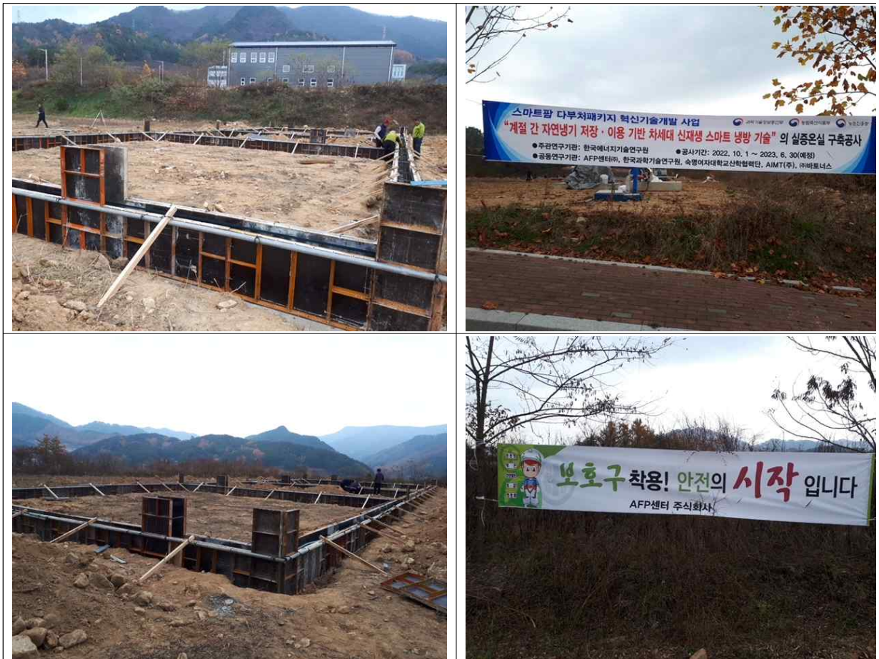
[그림 3. 실증 온실 설치 부지 기반 조성 사진]
