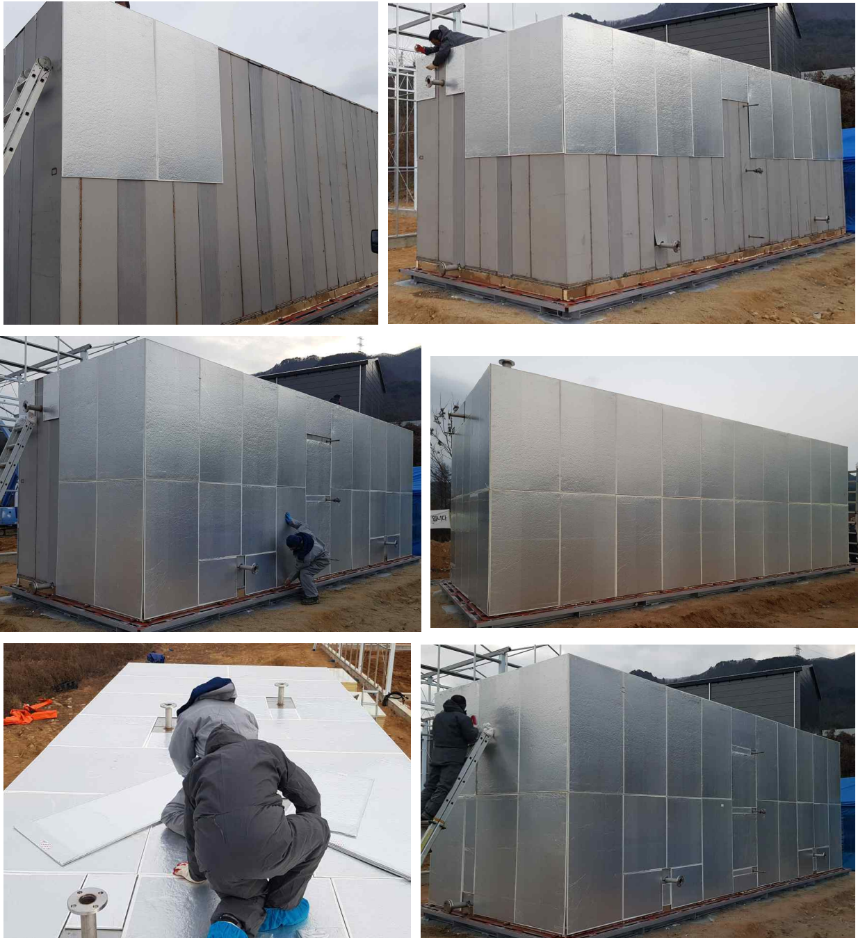
그림 2 축냉조 VIP 시공 현장 사진
