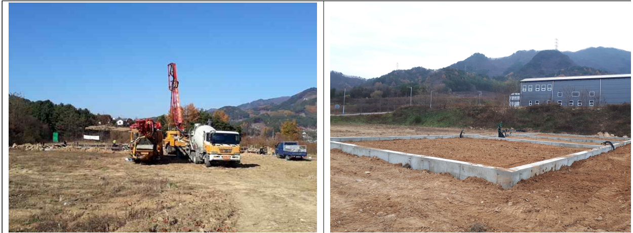
[그림 4. 실증 온실 콘크리트 벽체 구축 사진]
