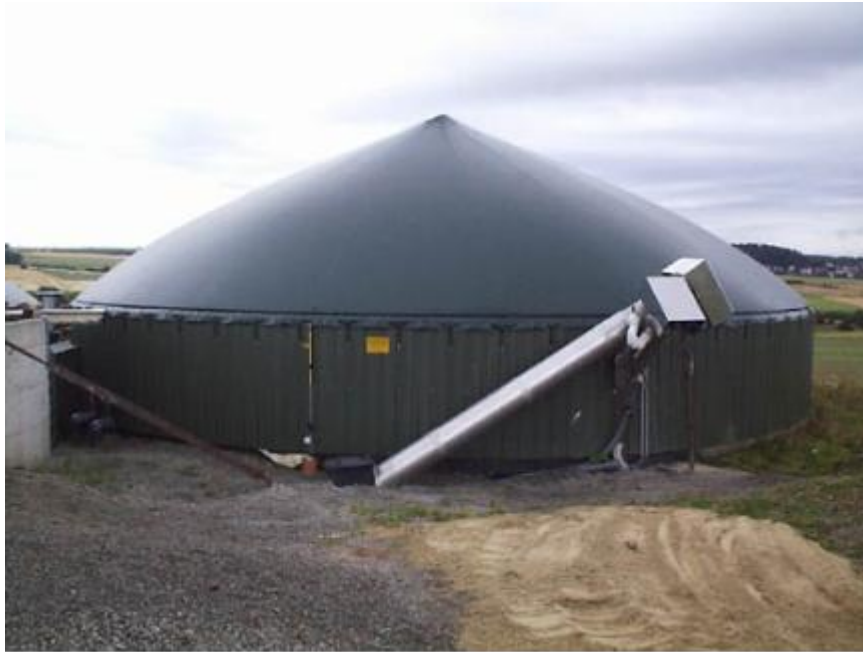
<그림 자료 1-12> 축산폐기물을 이용한 Bio-gas 생산시설
