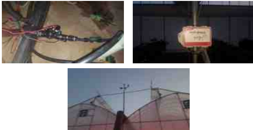
[그림 2-407] 스마트 관수제어 시스템 센서 설치 (좌상 : 전자밸브 및 유량센서, 우상 : 실내 센서노드, 하: 외부 기상대)
