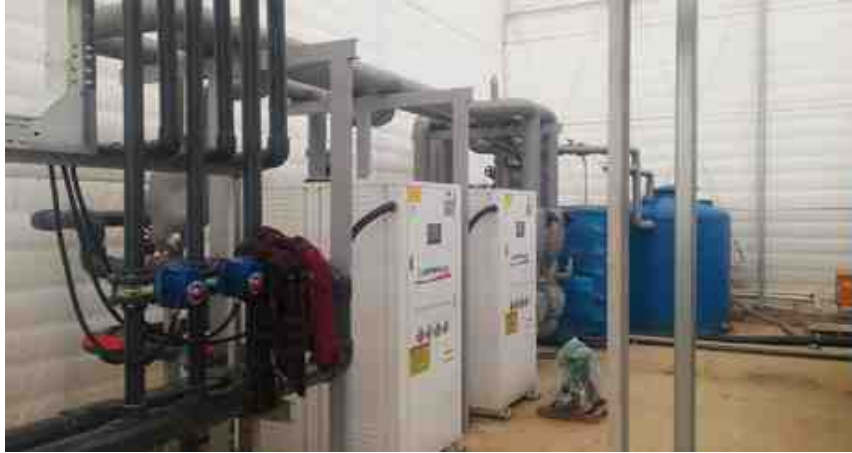
[그림 2-248] 스마트팜용 지열시스템(지오썸하이브리드) 기계실(온실)
