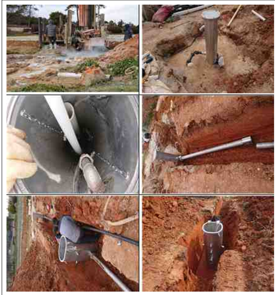
[그림 2-561] 지열공 및 상부보호공 설치모습
