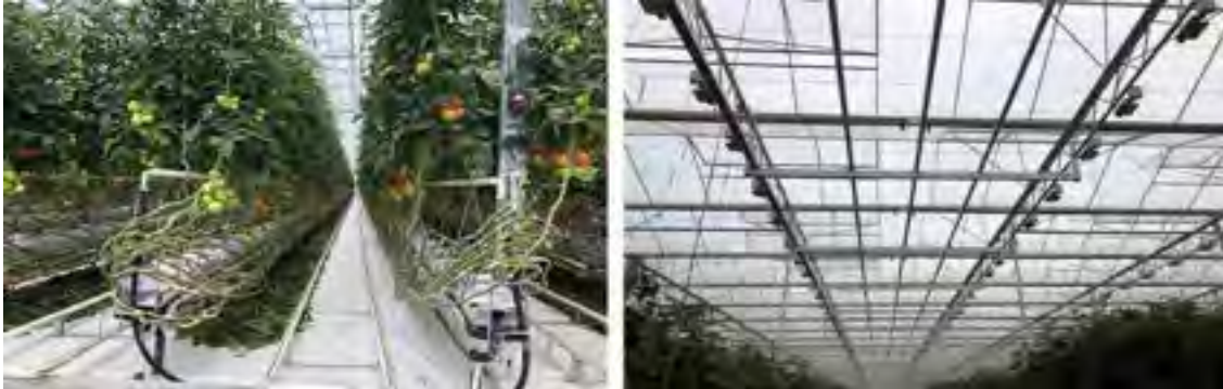
[그림 2-30] 난방 튜브이 종류(Rail Tube & Grow Tube(좌), 거터 난방 Tube(우))
