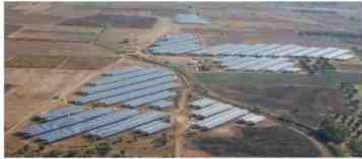
[그림 2-56] Sardinia에 설치된 가장 큰 규모 태양전지가 부착된 온실 단지 (20h, 20MW)
