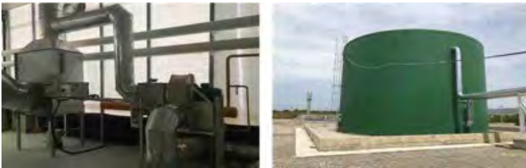
[그림 2-29] CO2 시비를 위한 설비(컨덴싱 유닛 & CO2 공급기(좌), 축열탱크(우))
