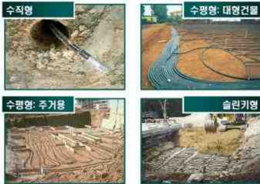
[그림 2-554] 지열히트펌프 시스템의 배치 종류
