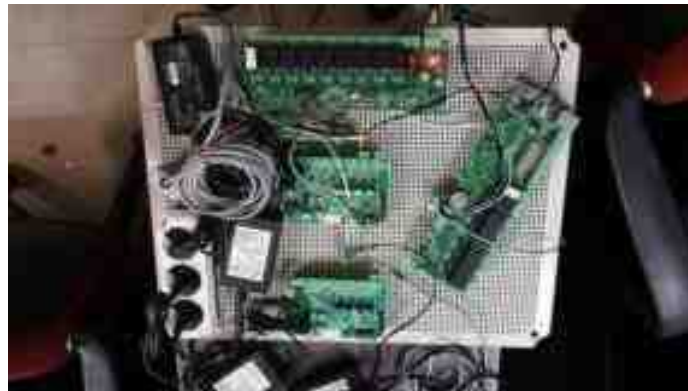
[그림 2-400] Main control 보드 시험
