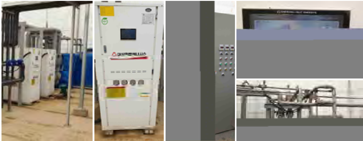
[그림 2-1070] 단일 순환 펌프형 지열 시스템
