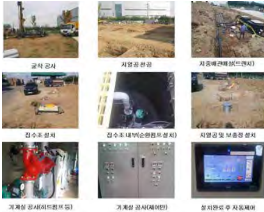
[그림 2-332] 스마트팜 지열시스템 설치 순서
