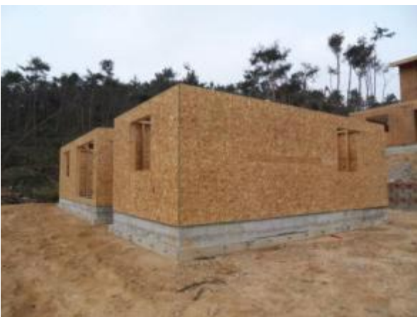
그림 A2-13. 패널 사이의 접합 및 골조의 완성
