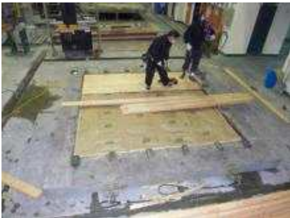
그림 A2-8. 두꺼운 목재 벽널의 설치
