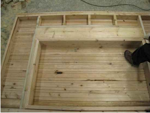
그림 A2-9. 헤더 및 아트월 틀의 설치
