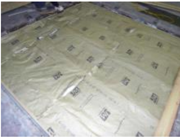
그림 A2-7. 단열재의 설치
