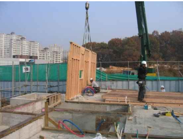
그림 A2-12. 패널의 설치
