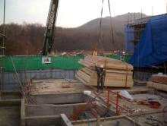
그림 A2-11. 공장에서 생산된 패널의 현장 운반 및 적재
