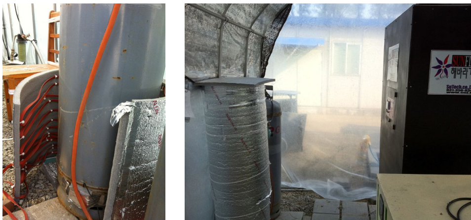
그림 90. LPG통 가온을 위한 열선 및 단열 처리
