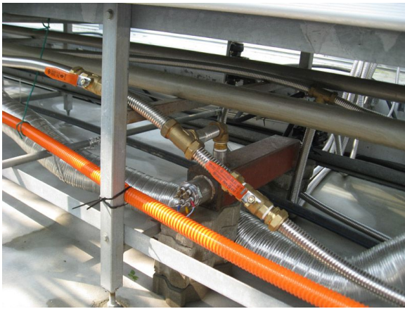
(a) 교체전 : 기존의 온실 배드 아래 난방수 전기히터 (5 kW)
