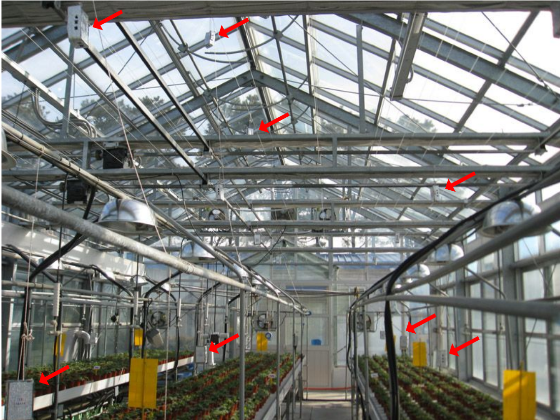
그림 83. 무선 온습도 센서 장착 사진
