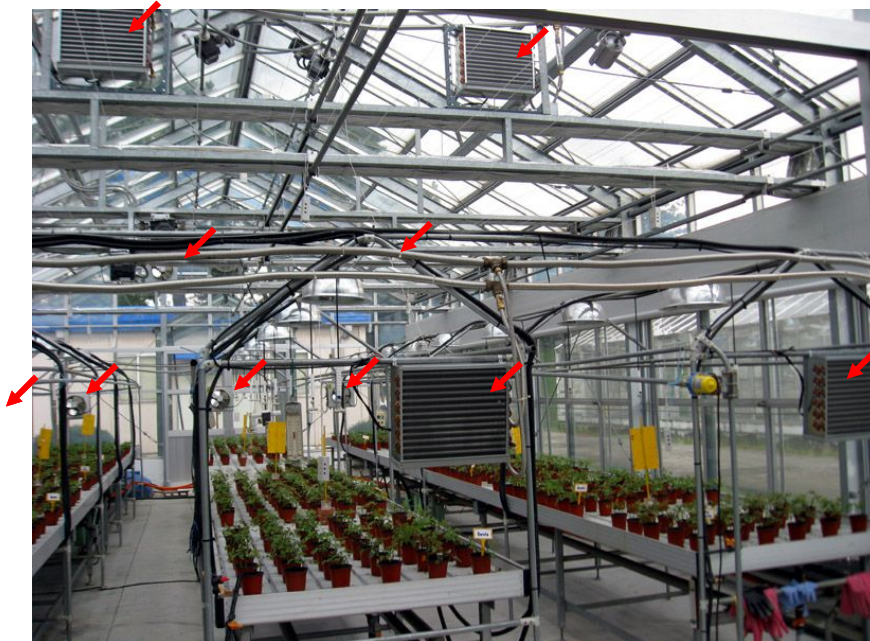
그림 72. 온실의 형태와 FCU 설치 위치 (FCU는 바닥에서 1.5m 위치에 6대, 바닥에서 4 m 위치에 4대, 총 10대가 설치되었다.)
