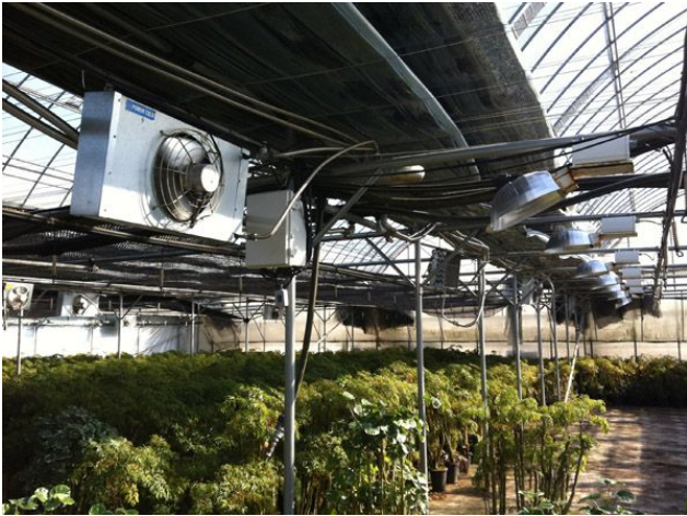
(a) FCU와 보광 설치
