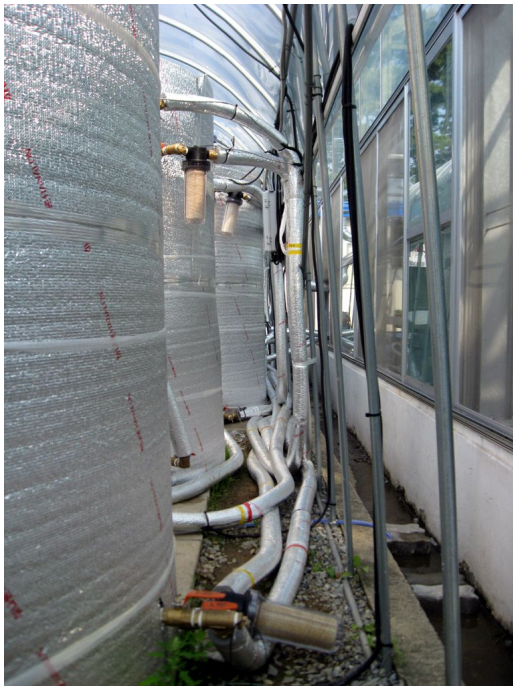
(a) 저온 물탱크(좌 2대), 고온 물탱크(우 1대)와 배관 및 필터
