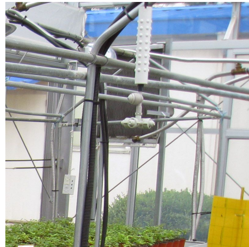
(b) FCU 응축수 받침 설치
