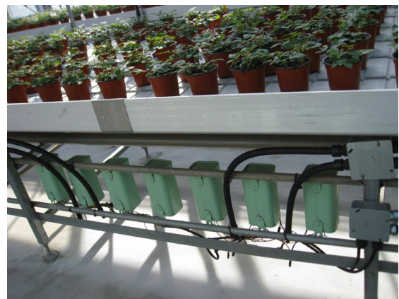
(b) 안정기 설치 위치 및 구조
