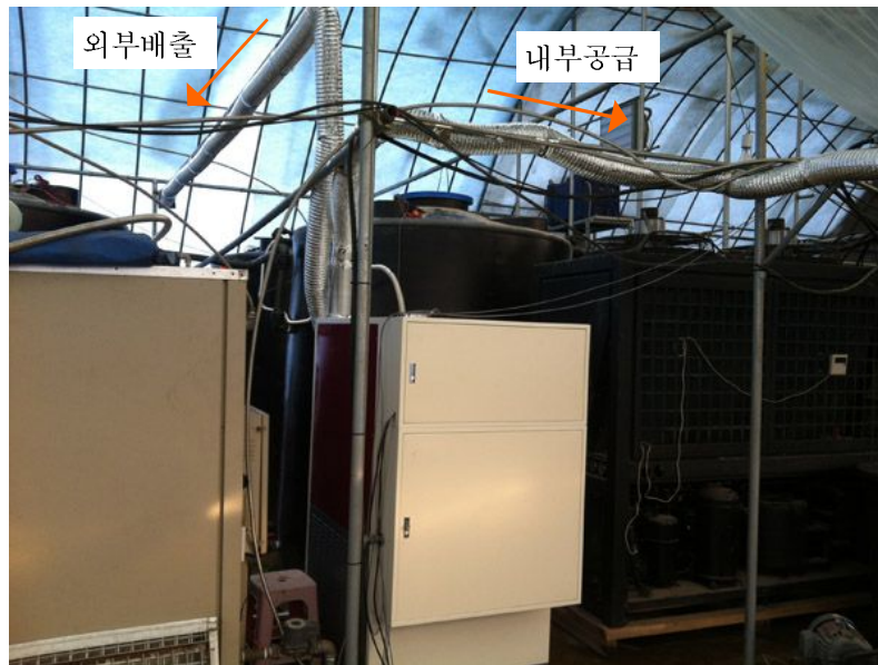
그림 134. 이산화탄소의 외부 배출 및 내부 공급 덕트 구조
