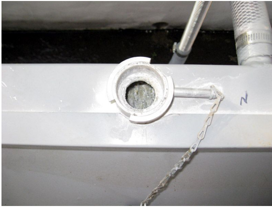
그림 87. 알루미늄 FCU의 지하수 부식 문제 발생
