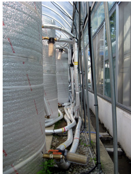
그림 85. 필터 장착 (물탱크의 모든 배출구 위치)
