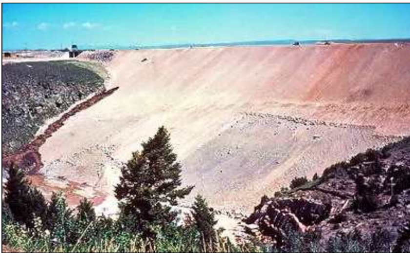
<그림 2-16> 댐 사면중간에 파이핑 발생(USBR)
