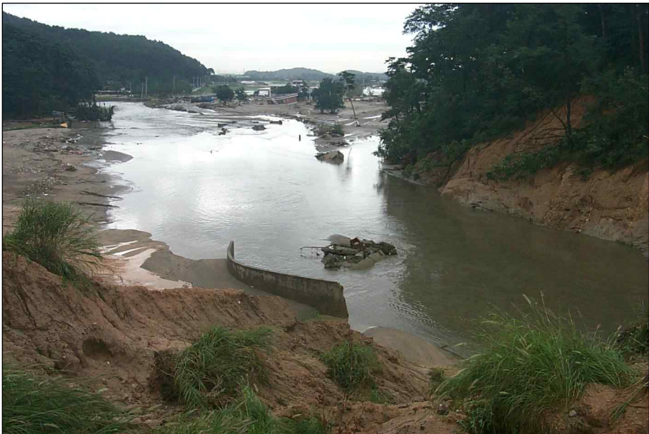
<그림 2-8> 장현저수지 붕괴 및 하류부 피해 현장
