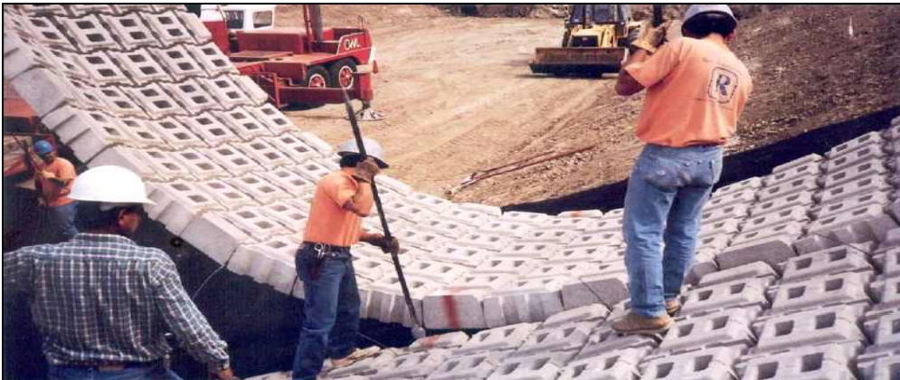
<그림 5-10> 댐 사면에 대한 조립된 콘크리트 블록의 거치
