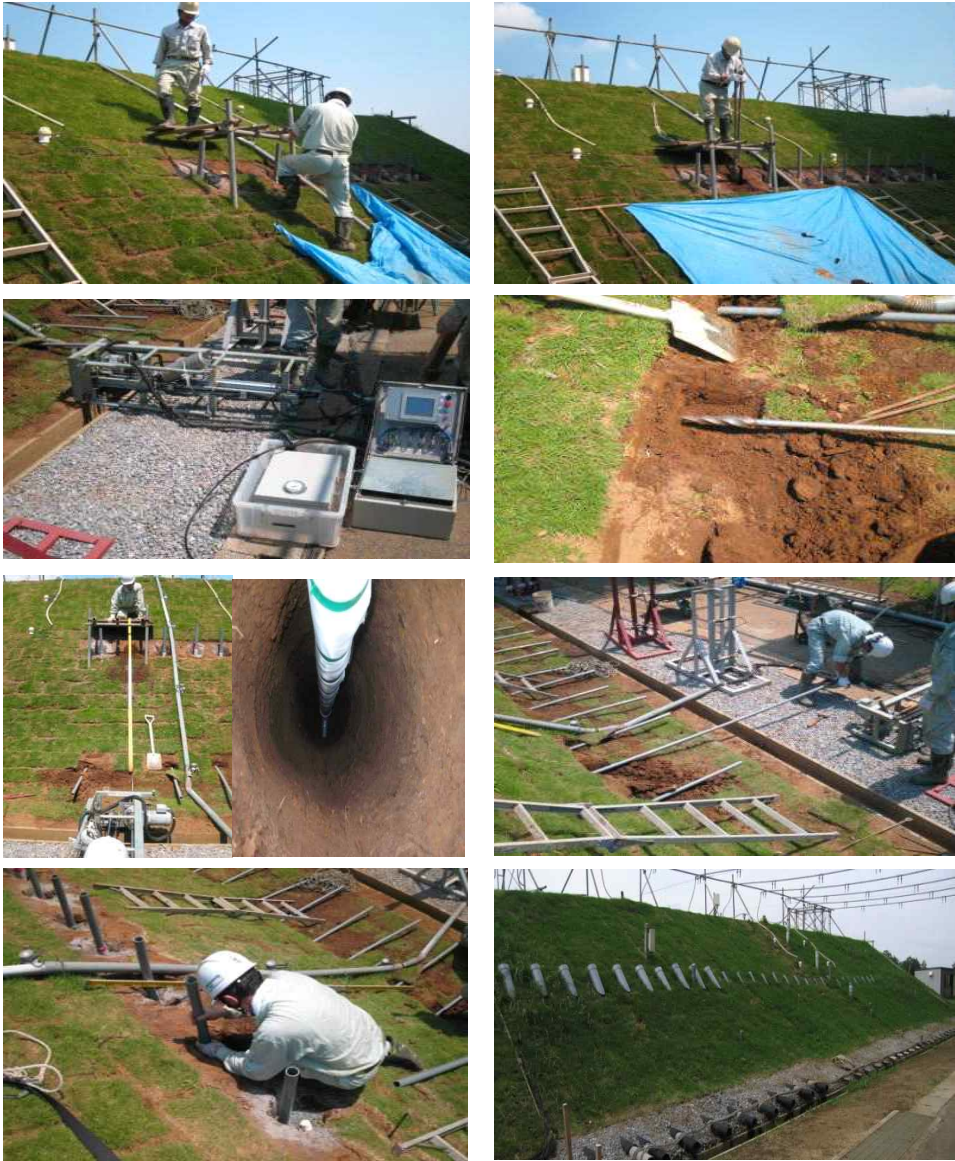
<그림 5-16> L형 드레인공법 단계별 시공전경
