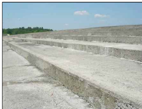
<그림 5-7> Tholocco Dam에 설치된 RCC 보조여수로
