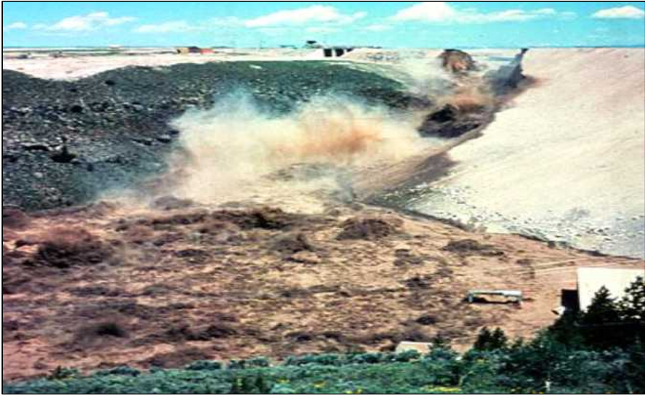
<그림 2-19> 댐 상부 붕괴 및 월류(USBR)
