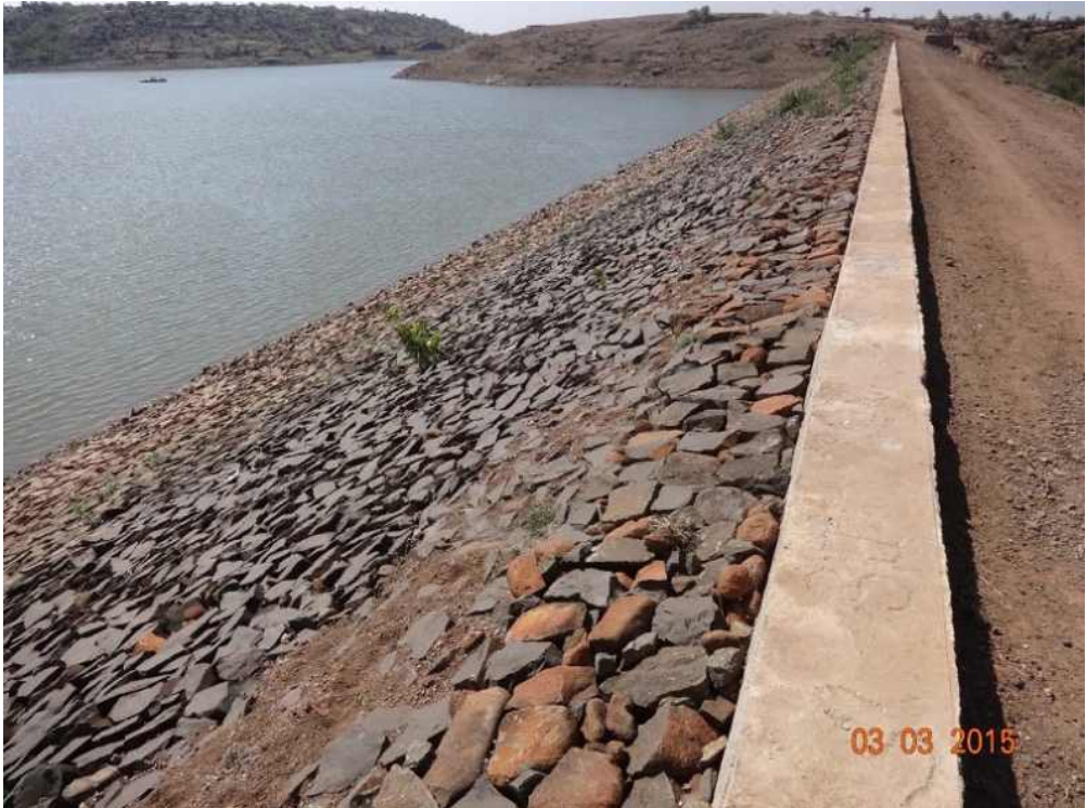
<그림 5-6> Parapet wall 설치 전경
