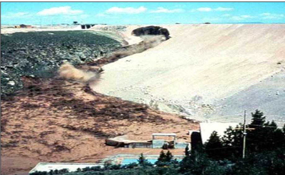
<그림 2-18> 댐 공동 확대 및 상부로 진행(USBR)
