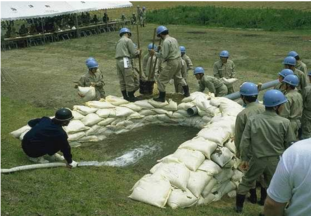
<그림 5-17> 월륜공법의 현장시공 전경
