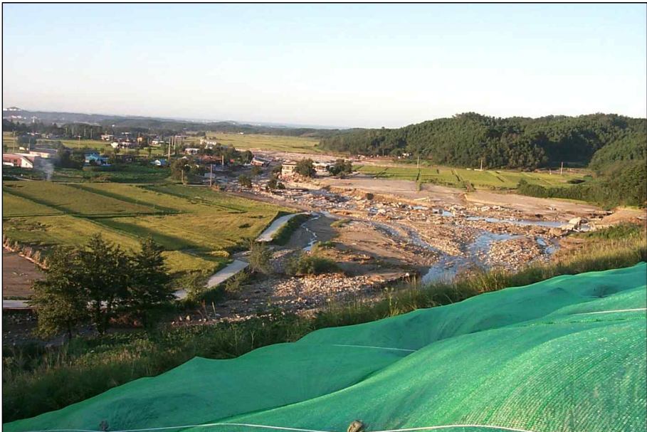
<그림 2-10> 동막저수지 붕괴 및 하류부 피해 현장
