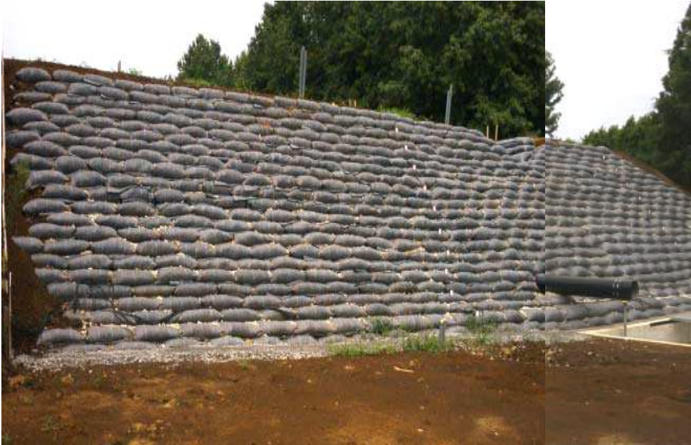
<그림 5-14> 제체에 적용한 흙부대 공법
