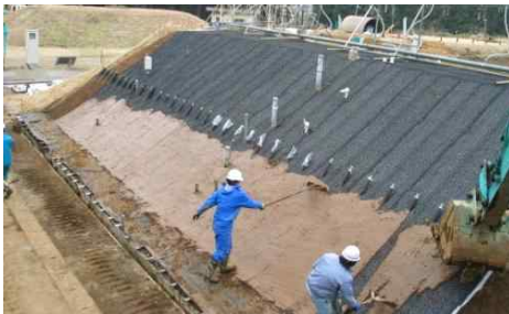
<그림 5-15> 제체표면 피복공법 단계별 시공전경
