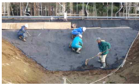
<그림 5-15> 제체표면 피복공법 단계별 시공전경
