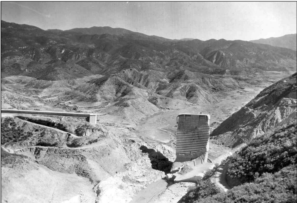
<그림 2-23> 붕괴 후 성프란시스 댐(USGS)
