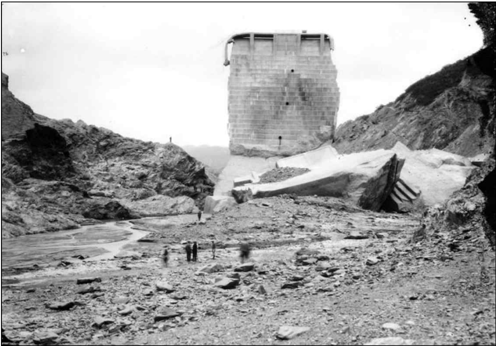
<그림 2-25> 붕괴 후 성프란시스 댐 전면(USGS)
