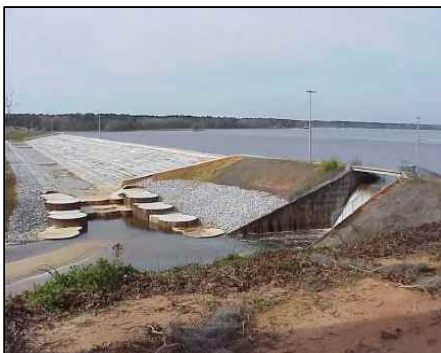
<그림 5-7> Tholocco Dam에 설치된 RCC 보조여수로
