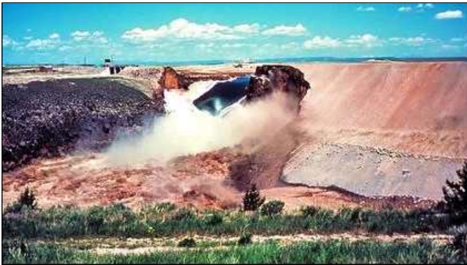
<그림 2-20> 댐 상단 파이핑 진행 붕괴(USBR)
