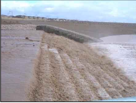
<그림 5-8> Red Rock 유역의 댐에 설치된 RCC 보조여수로 출처 : Small Dams Design, Surveillance and Rehabilitation(CIGB ICOLD)
