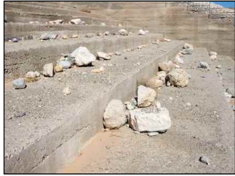
<그림 5-8> Red Rock 유역의 댐에 설치된 RCC 보조여수로 출처 : Small Dams Design, Surveillance and Rehabilitation(CIGB ICOLD)
