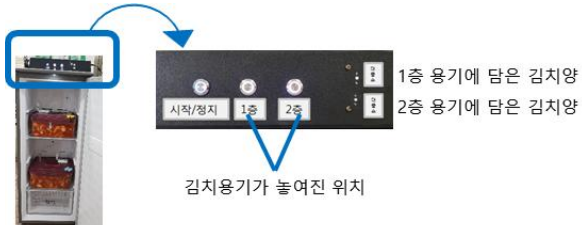
그림 29. Simplified control box placed on top of refrigerator.
