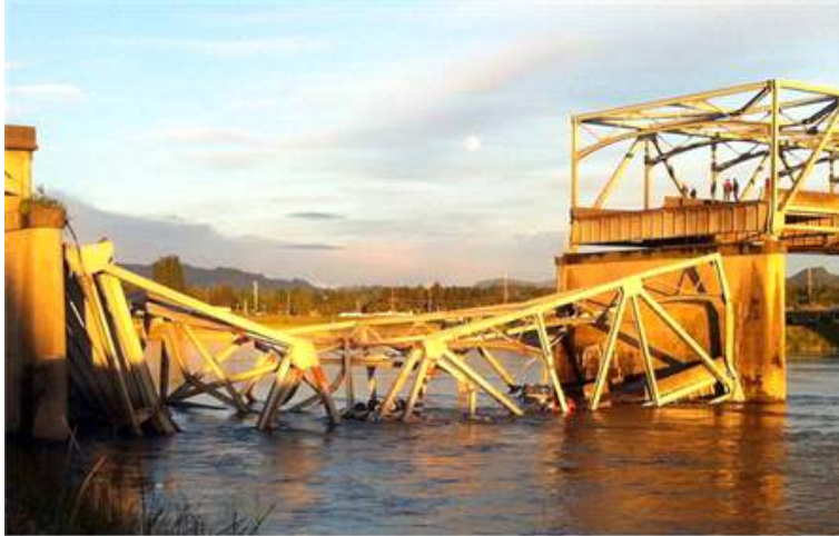
< 그림 4.3 > 워싱턴주 교량 붕괴
