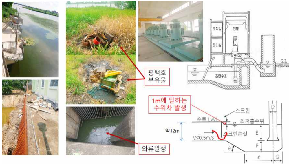
< 그림 2.27 > 부유쓰레기 유입에 따른 흡입수위 저하, 와류 발생
