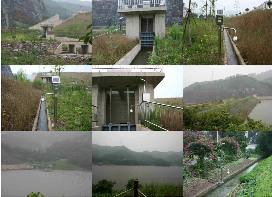
<그림 2-30> 물관리 구간별 시설 및 수문의 상태
