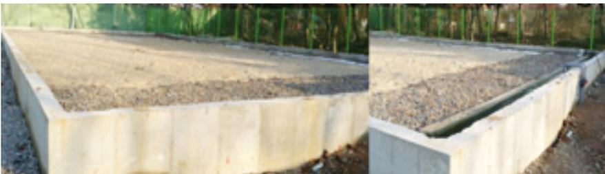
[그림 4-98] 방류수 안정화 습지 설치 예시
