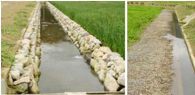
[그림 4-48] 습지 제방 및 독 설치사례 (감둔지구 1호 습지, 2007년)
