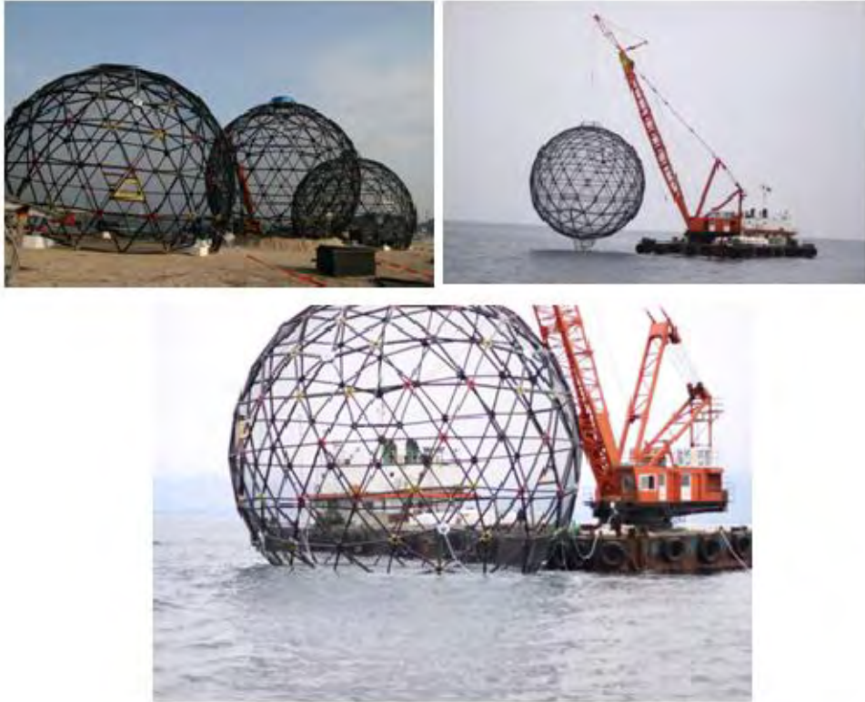
그림 35 가두리 이동과 설치 진행
