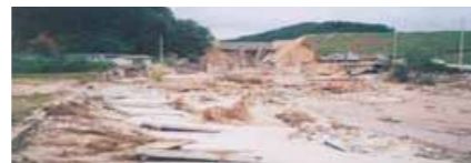
▲ 폭우로 인한 저수지 붕괴
