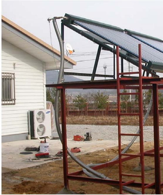
그림 12 태양열 집열판의 설치
