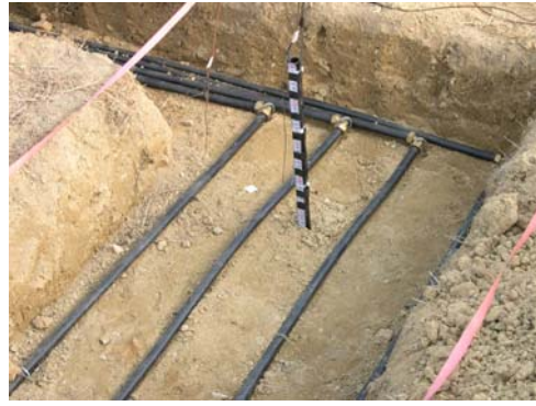
그림 9 온도센서 설치
