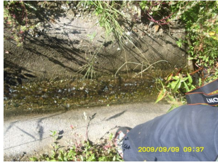
논-배수로 물 흐름 현황 2
