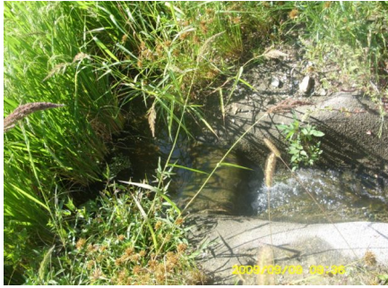
논-배수로 물 흐름 현황 1
