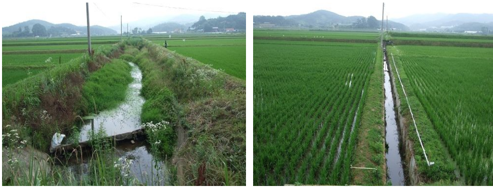
<그림 3-21> 토공배수로 및 콘크리트 용수지선
