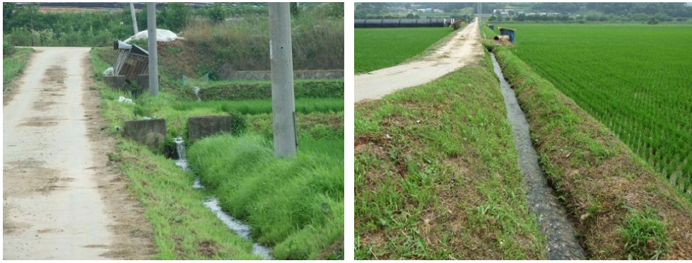
<그림 3-19> 토공용수로 모습
