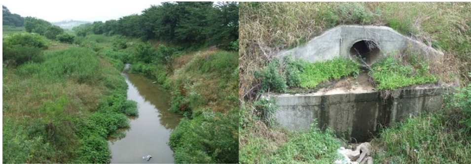
<그림 3-20> 토공배수로 및 유입하천에 연결된 배수관 모습
