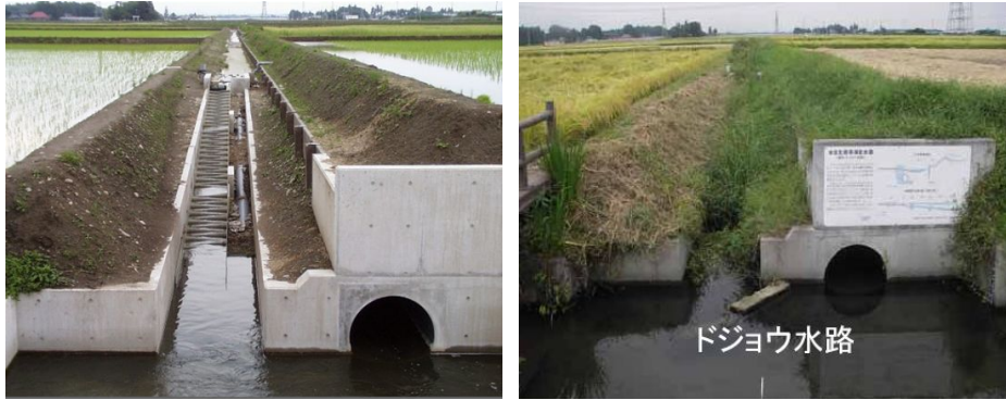
<그림 2-13> 생태수로와 배수로 분리 설치 사례 (표 2-2) 도치키현 어도설치 후 이용어류 조사결과
