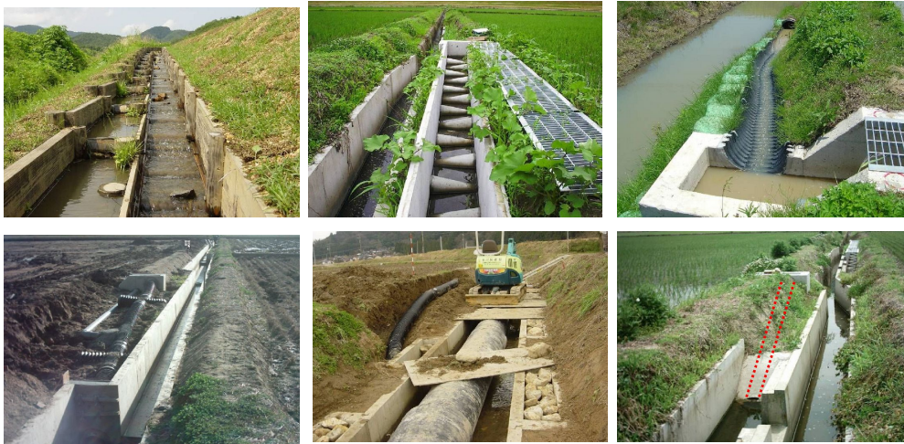
<그림 4-3> 설치방법별 분류(상 : 개거형, 하 : 암거형)
