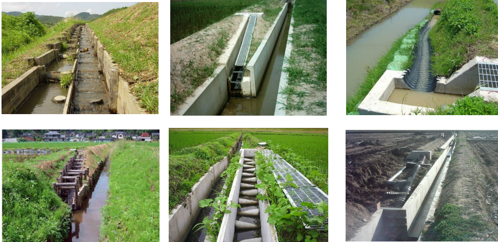
<그림 4-2> 재질별 분류(좌 : 목재, 중 : 콘크리트, 우 : 폴리에틸렌)
