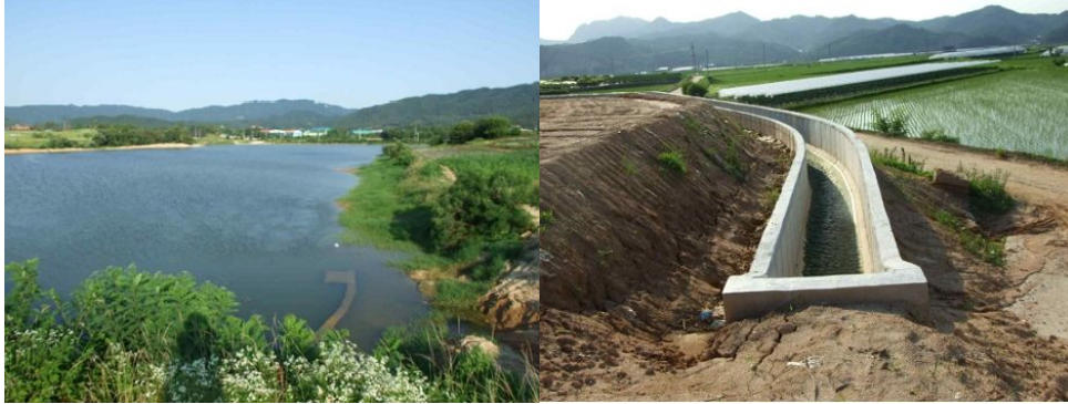
<그림 3-9> 백매저수지 전경 및 용수로 확장공사 모습
