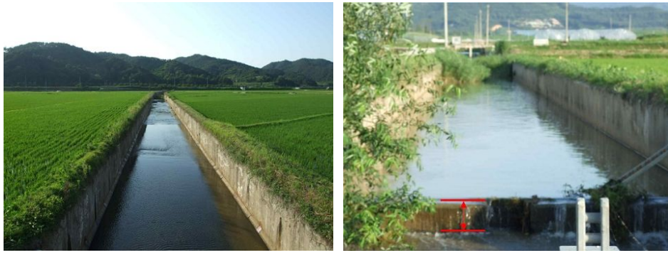
<그림 3-13> 주 배수로 전경과 하류 하천 합류지점 부근 모습
