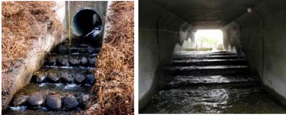
<그림 3-45> 배수 암거부의 친환경적인 구조개선(계단식 연장)
