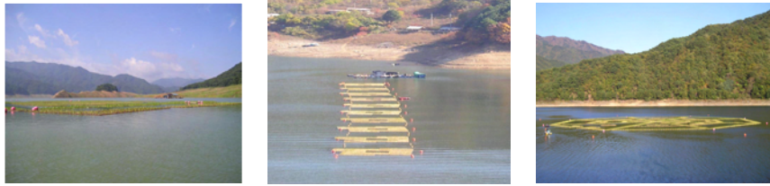
<그림 3-59> 저수지 수변부에 시공사례(자료 : 아썸 기술자료)
