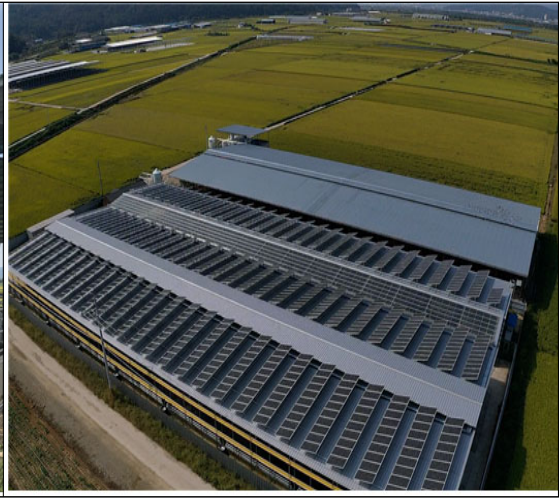
<그림 3-25> 농업진흥지역내 축사 위 태양광 패널 설치 현황((경북 K시)
