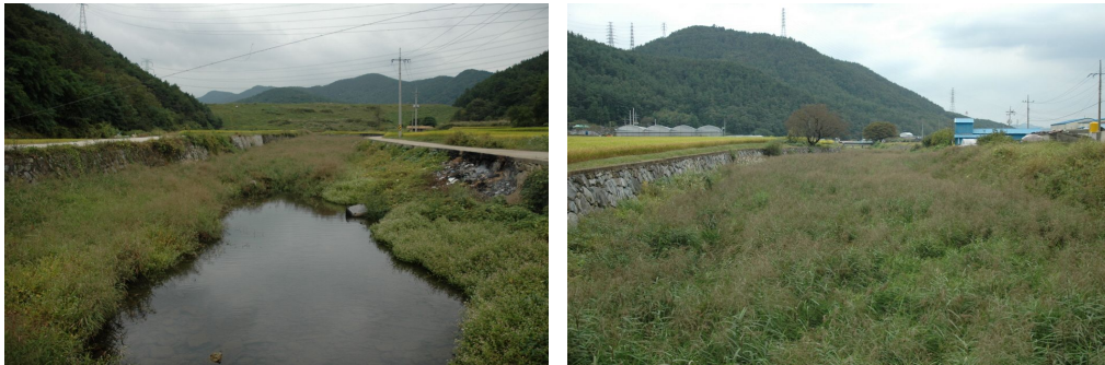
<그림 4.13> 고성군 하이면(봉현천) 하천 상류 전경
