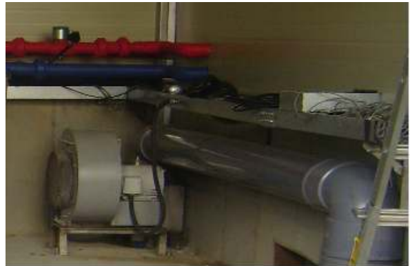
<저류조내 환기배관 및 터보팬 설치사진>
