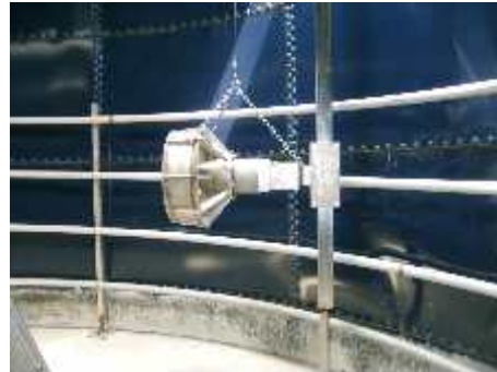
<교반기의 설치 및 내부 가온배관설치>
