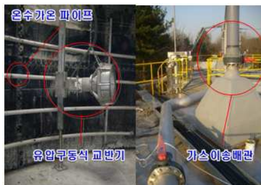
<내부 및 외부시설>
