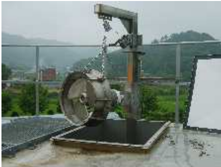
<교반기의 설치 및 내부 가온배관설치>
