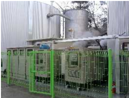
<폐열병합 발전기의 현장 설치 사진>
