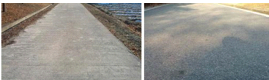
<도로 형태(콘크리트 및 아스팔트)에 따른 토크 측정>
