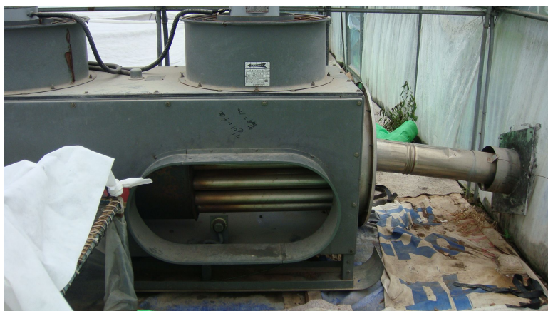
그림 16 Bed 하부 온풍 공급을 위한 열풍장치
