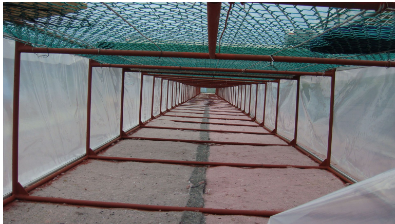
그림 15 Bed 하부의 온풍 공급을 위한 공간의 구성
