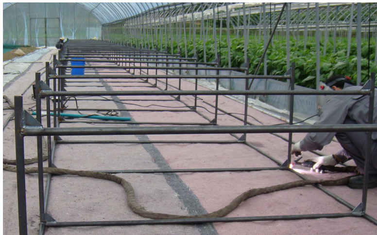
그림 12 고추 탑재 Bed의 지지 프레임 제작
