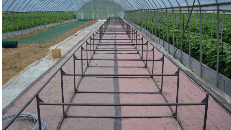
그림 13 고추 탑재 Bed의 지지 프레임 및 이동 레일의 조립
