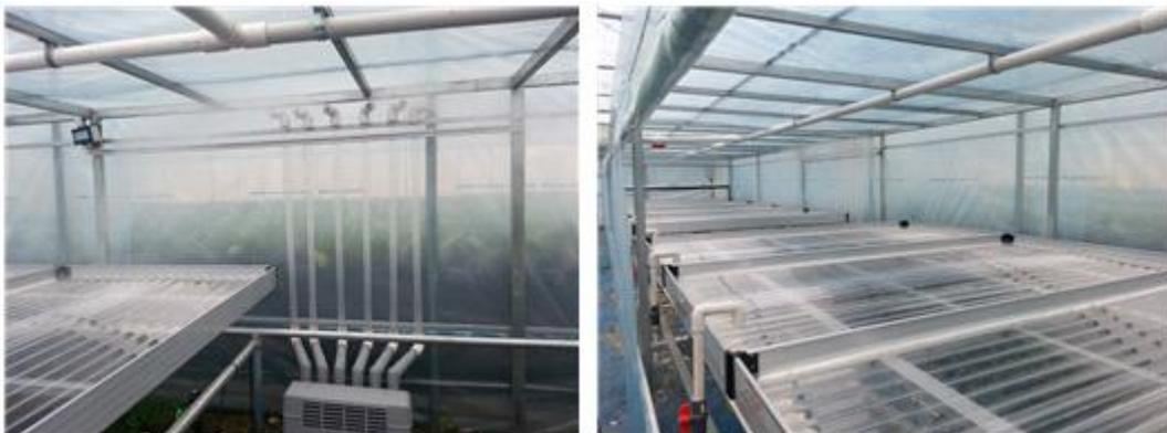
(그림 3-37) 마이크로포닉시스템 구축(습도 조절 및 양액급액 시스템 설치).
