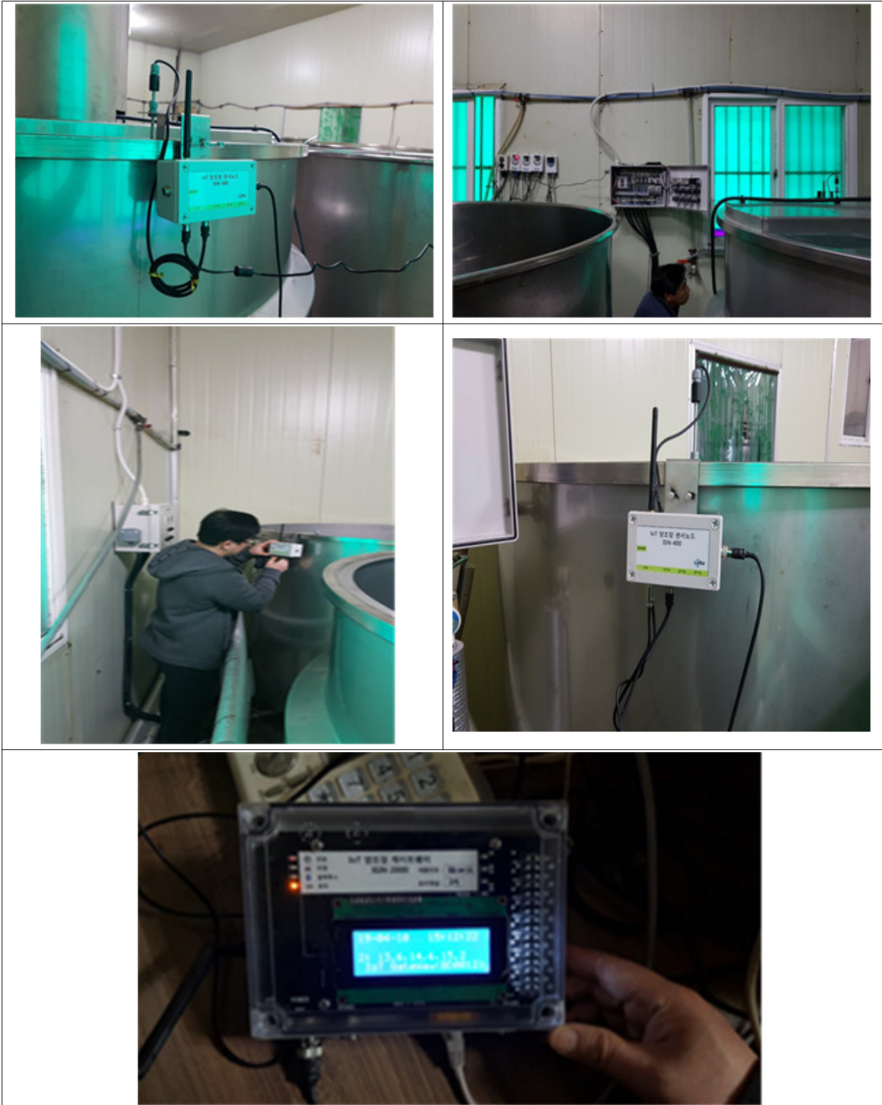
(마) 우리도가 현장 설치 사진
