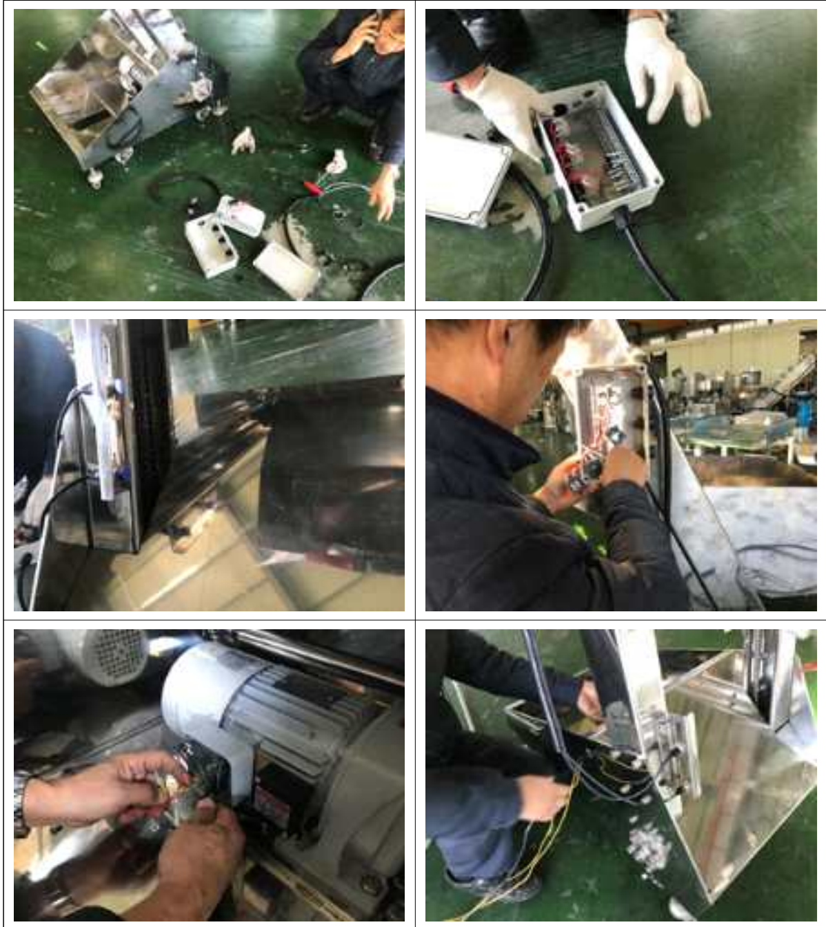
그림 137 Bucket Lift 제어장치 설치
