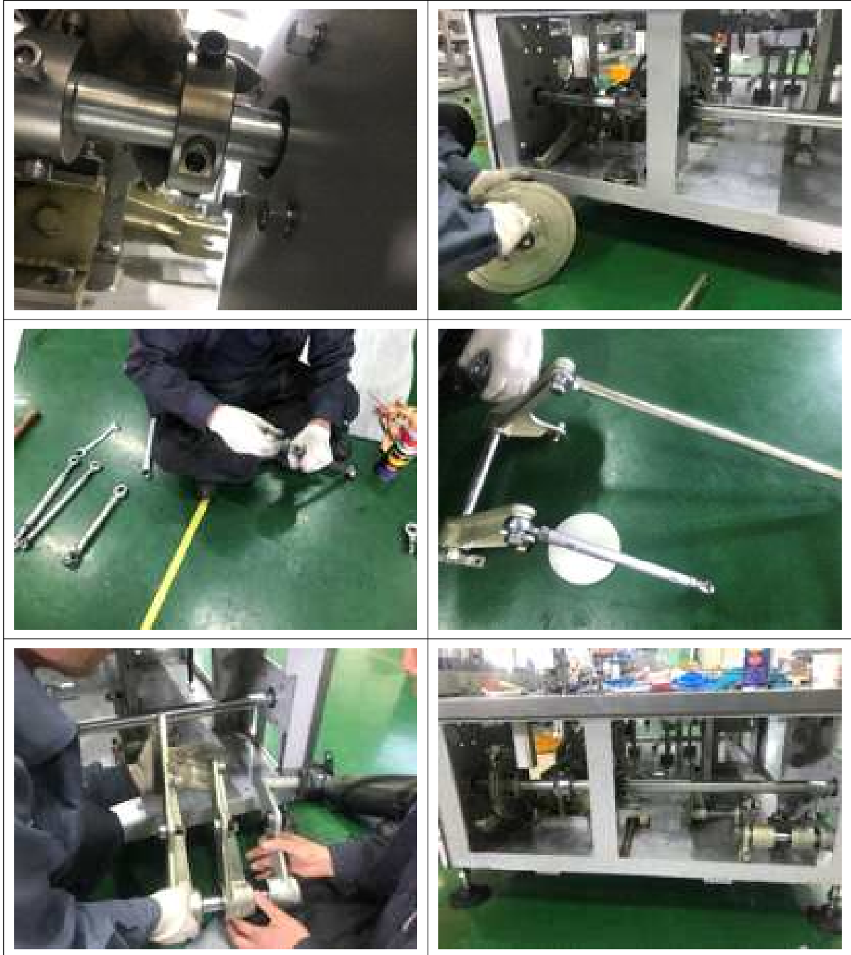
그림 142 브라켓 및 구동축 링크 설치
