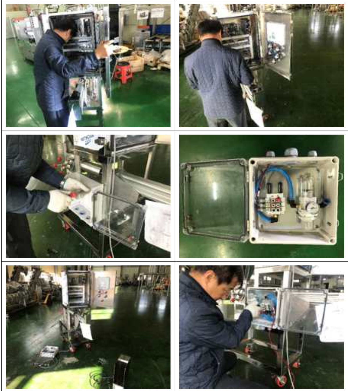
그림 128 Filling Unit 전기제어함 설치
