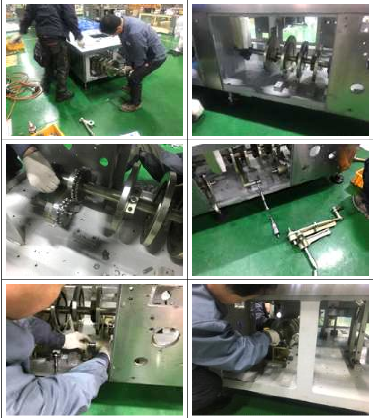
그림 140 Cam 및 Main Shaft 설치
