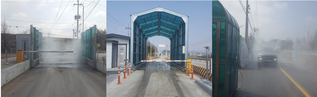
마니커 충주지점 소독시설
