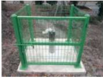
1) 관측공 굴착, 보호시설 설치
