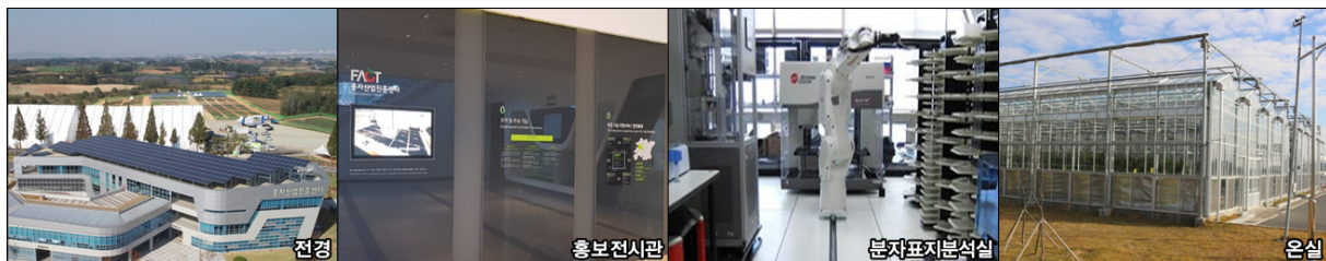
〈부그림 6-11〉 종자산업진흥센터 시설 현황
