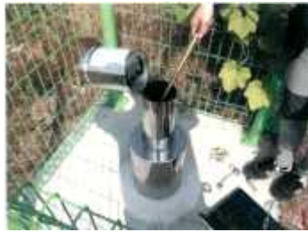
3) 관정내장형 관측장치 설치
