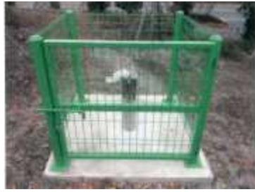
1) 관측공 굴착, 보호시설 설치
