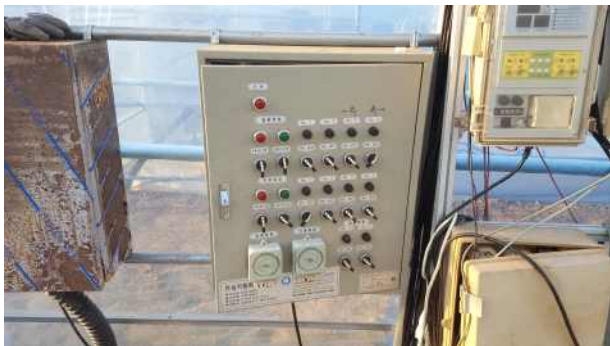
컨트롤 박스 설치
