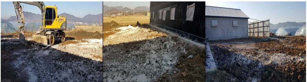
그림 32. 현장 복토 작업 후 생석회 소독
