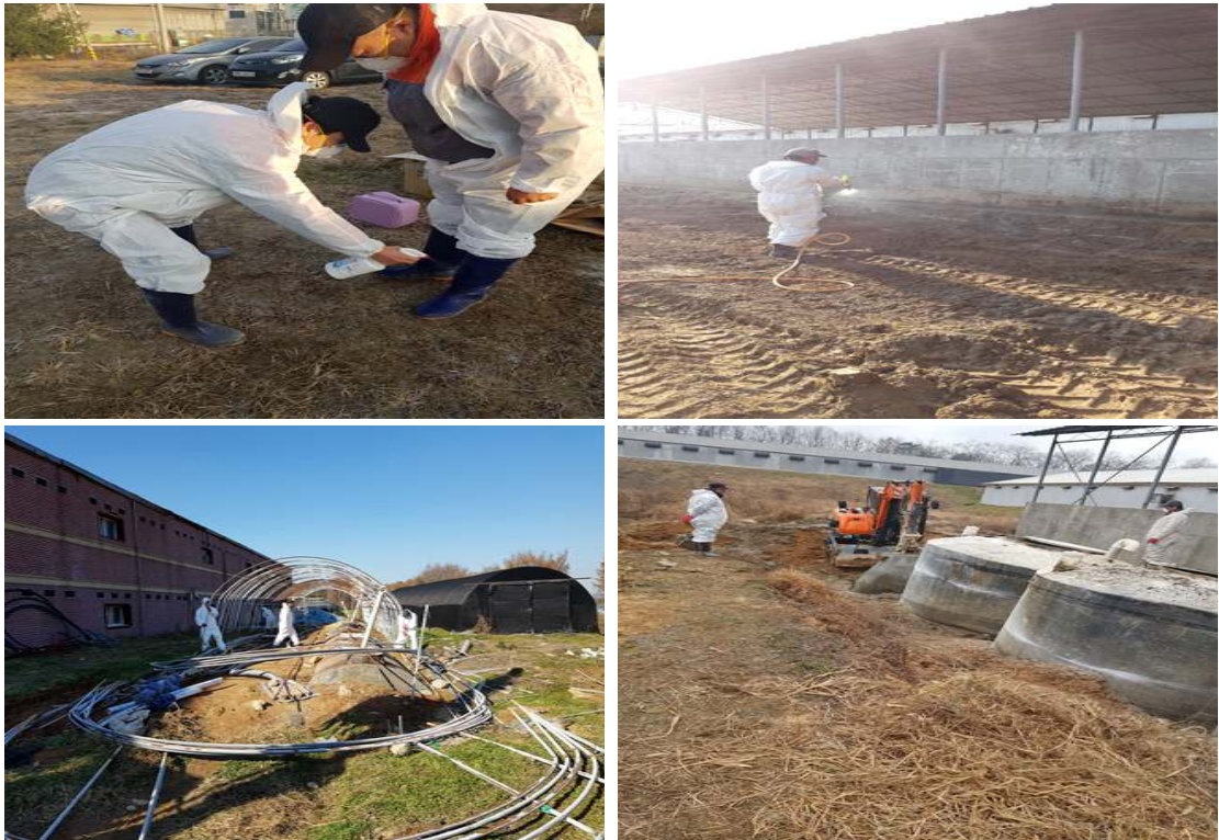
그림 27. 작업 전 (개인 보호구 및 방역복 착용, 현장 방역, 매몰지 굴착 토목 작업)
