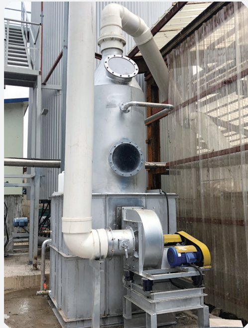
악취저감설비 설치 전경
