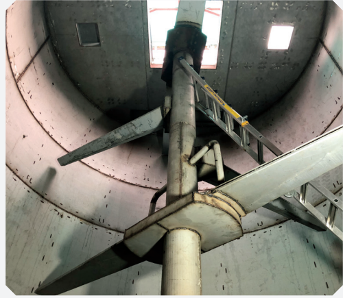
컴포스트 내부 교반날개 조립
