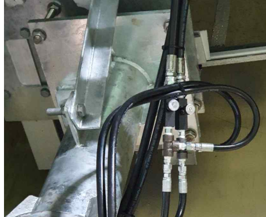
<그림 9> 속도 조절 장치 설치
