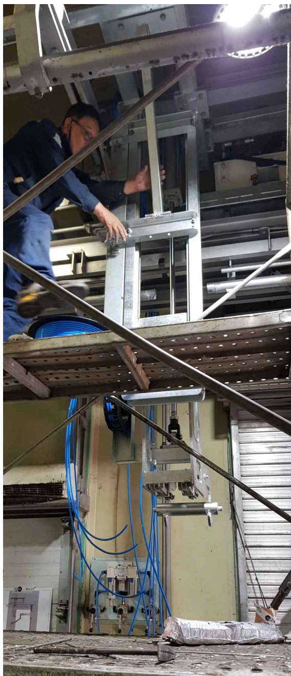
<그림 38> 후구 하강장치 설치공사
