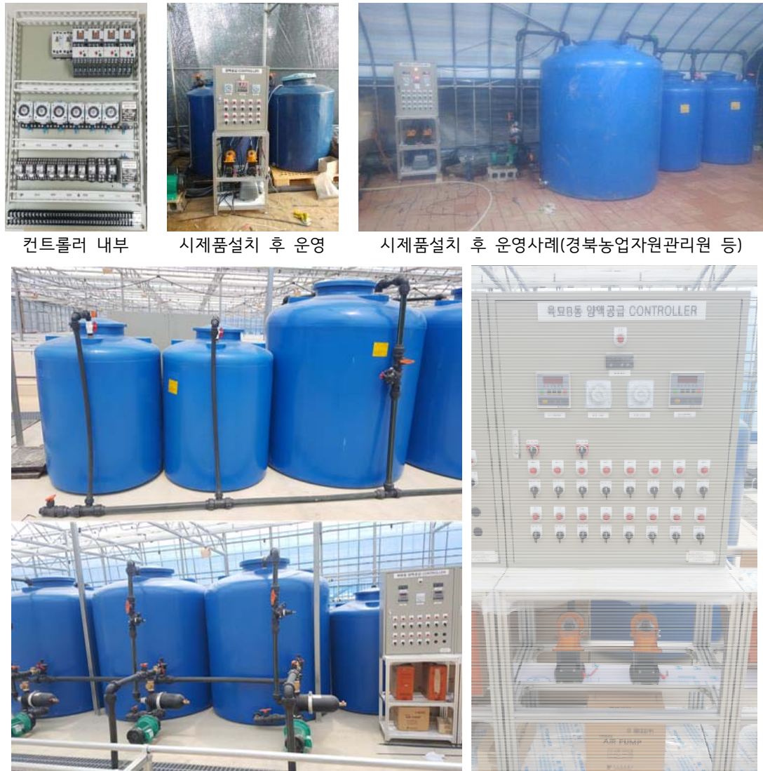
그림 12. 정량펌프식 양액·관비시스템 설치 모습
