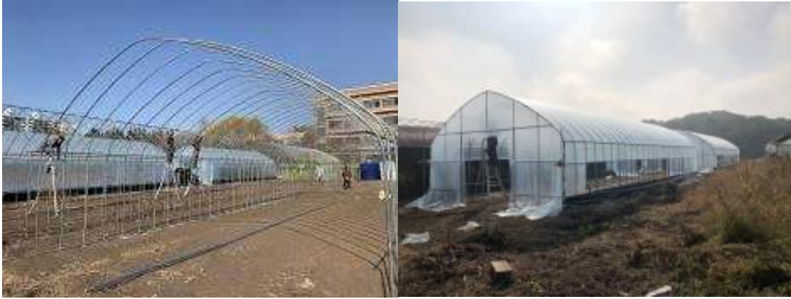
그림. 온실(스마트팜) 건설 사진.
