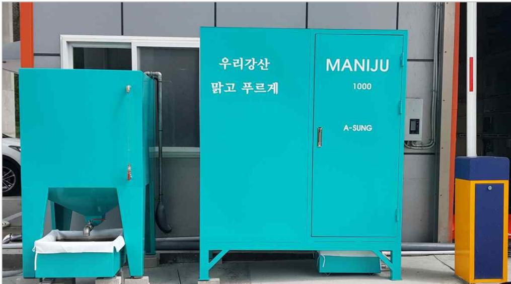
[그림 77] 경북 영주시 거점 설치사진 (슬러지탈수장치(좌), 정화배출 장치(우))
