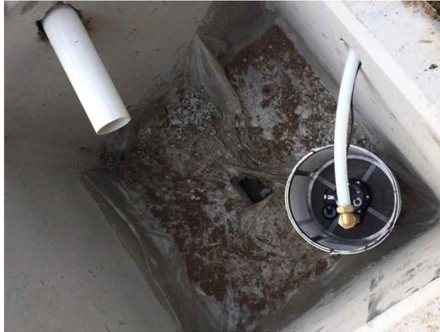
[그림 22] 침전조 메쉬망 설치 모습 2
