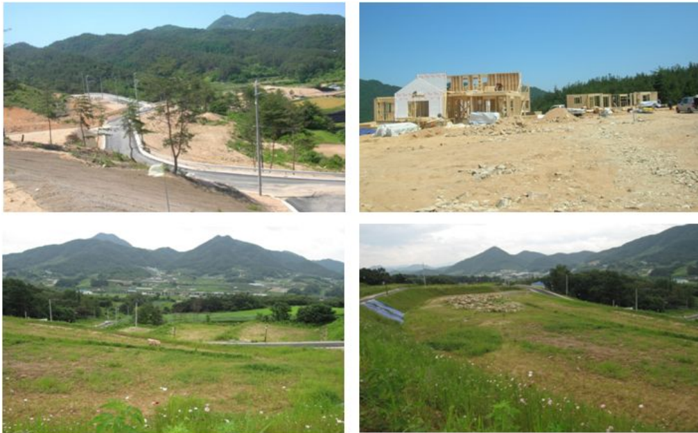
그림 3-30. 전원마을 조성사업 대상지 전경
