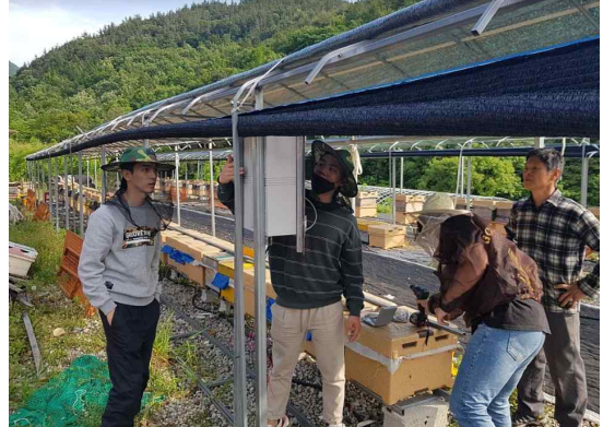
<중계기장치 설치 사진>
