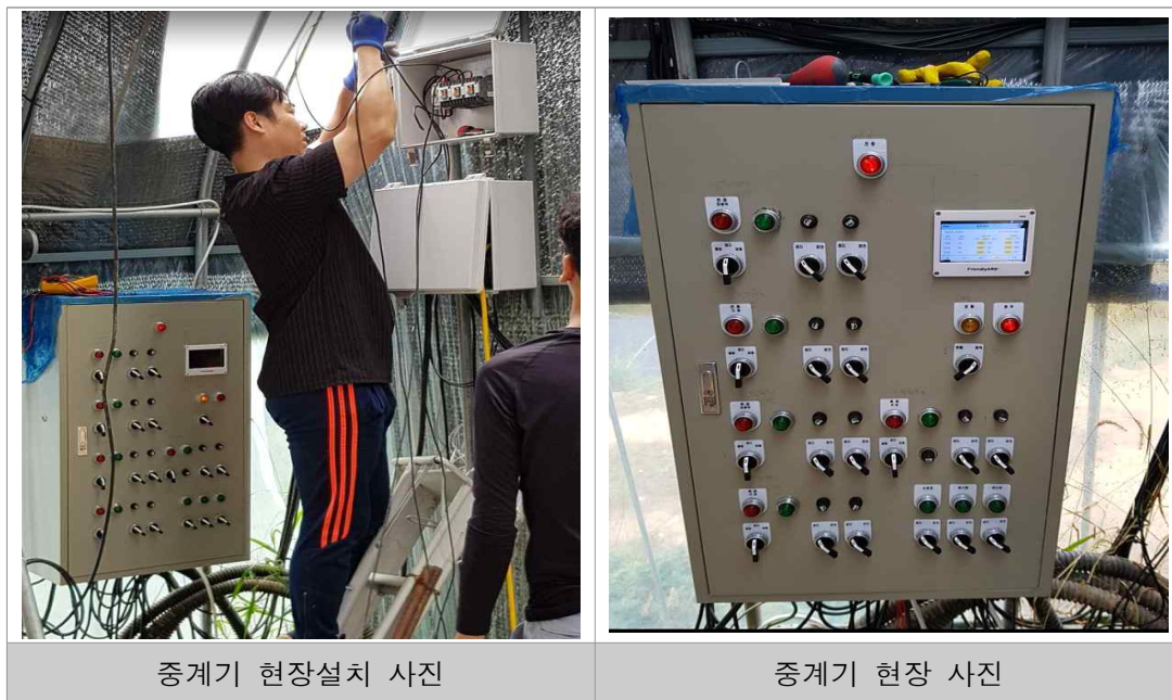
그림 22. 중계기 현장설치 테스트 사진
