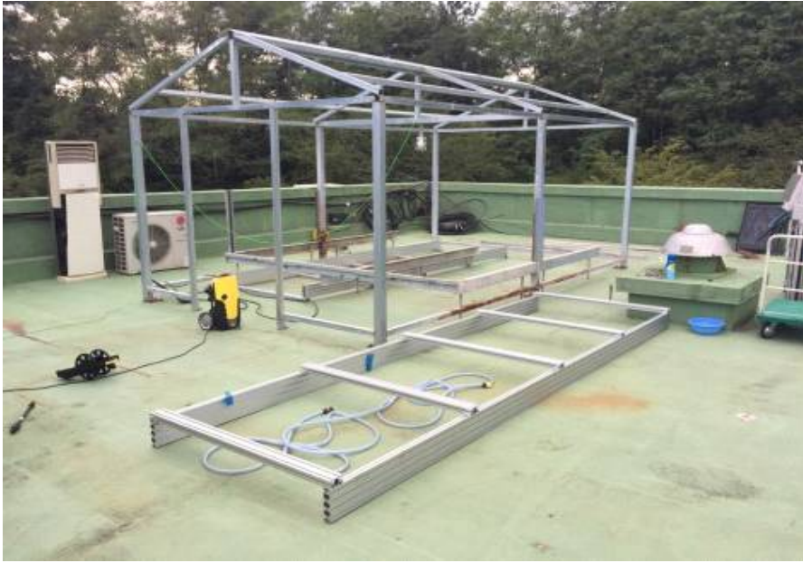
그림 3. 축사 테스트베드 기초 골조 작업
