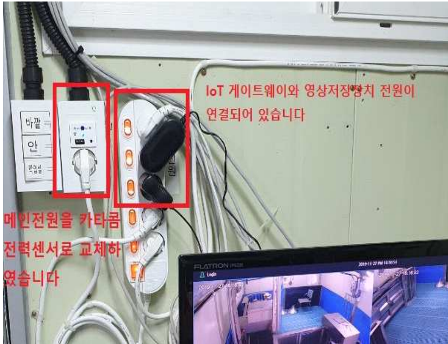
그림 9. 테스트베드 제어실 내부에 전력센서 설치
