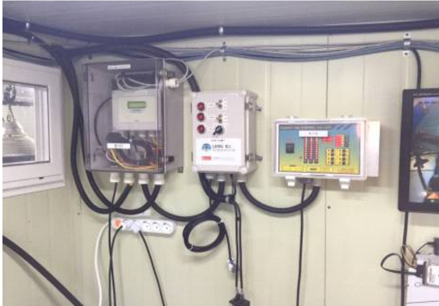
그림 12. 테스트베드 제어실 내부에 제어 컨트롤박스 설치 (LEMS)
