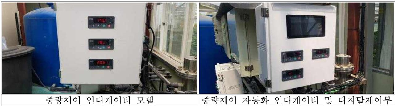
그림 53. 중량제어 자동화 급액시스템 인디케이터 및 제어부
