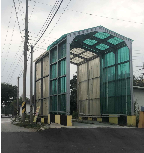
단지 입구 진입로의 공동 차량 소독 시설 설치 단지 진입로의 차량 소독 시설 그림 35. 단지 입구 공동 차량 소독 시설 설치 예(익산 함열 양돈 단지).
